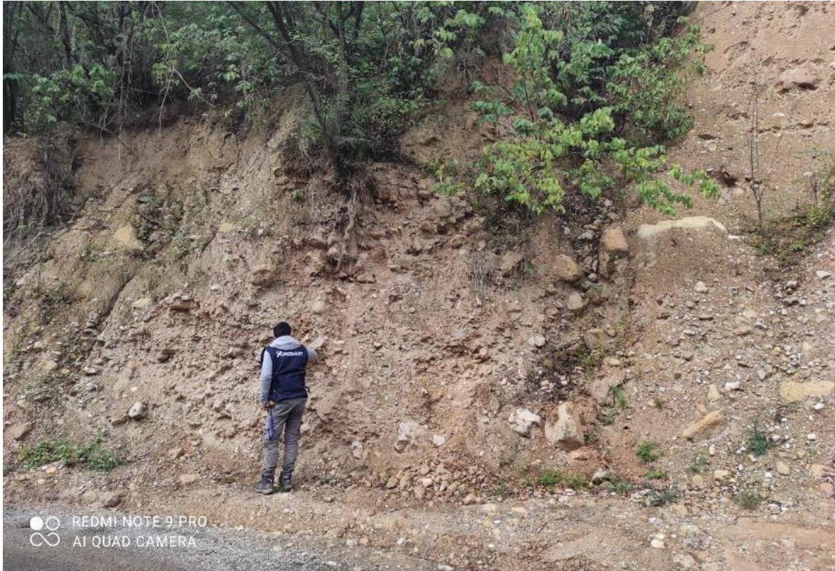
Fotografía 3: Vista tomada margen derecha de la quebrada Chaquillo coordenadas UTM zona 18: 278548.89 m E - 8970878.12 m S, se observa depósitos coluviales compuesto por bloques y cantos angulosos de tamaños variables.
