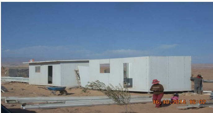
Figura 10. Armado de módulos de vivienda en las pampas de Jaguay
