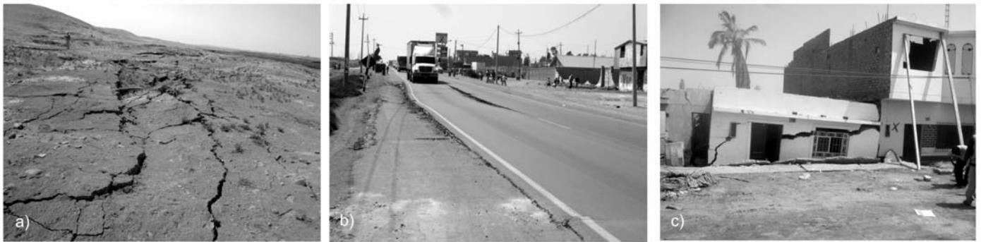
Figura 10: Sectores de La Hoyada (a), Panamericana Sur (b) y Tambo de Mora (c), con fuertes agrietamientos asociados a procesos de licuación de suelos.
