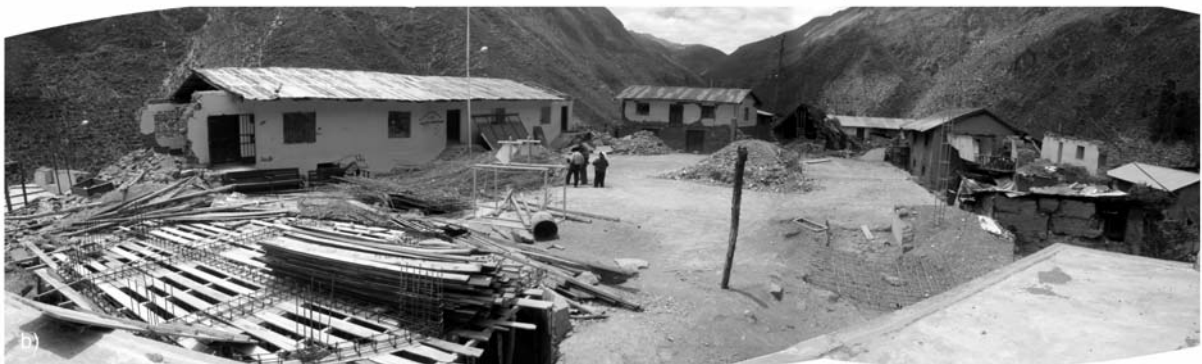
Figura 20: Laraos a) Ubicada sobre antiguo deslizamiento; b) Reacomodo del depósito originó daños en las viviendas ubicadas en la cima del depósito.
