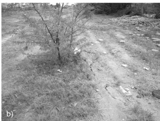
Figura 6: Compresiones, producto de las cuales se presentaron abombamientos en el terreno.
