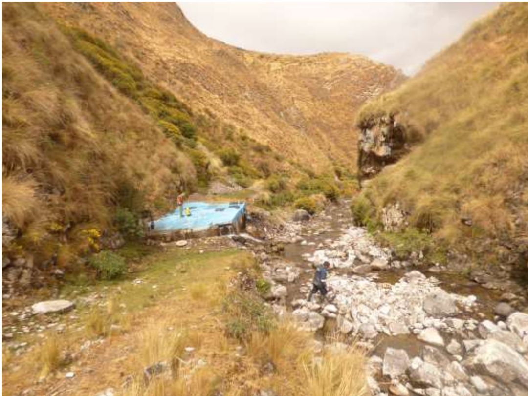
Fotografía 9.3. Aguas superficiales del río Chía y captación Ancall ubicada en la margen izquierda. Se sugiere represar estas aguas en la parte alta del río Chía, para incrementar el volumen de abastecimiento.
