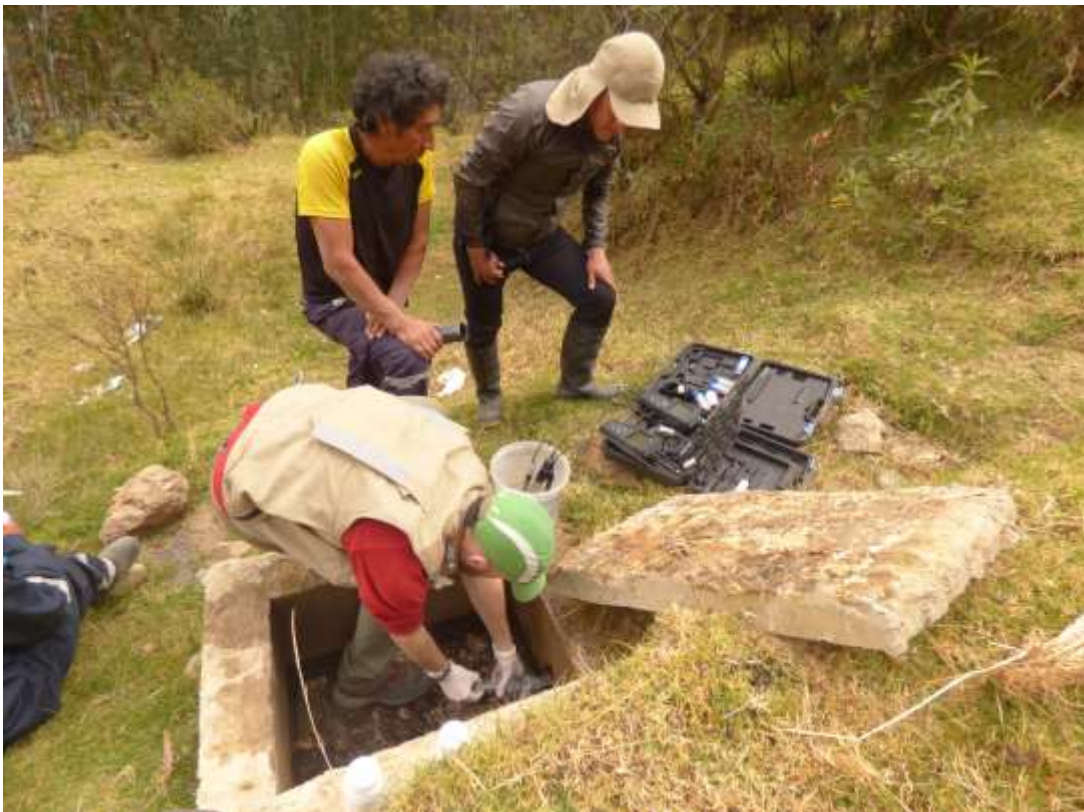
Fotografía 7.11 Manantial Vitas 1, nótese la cámara de reunión con filtros de grava.
