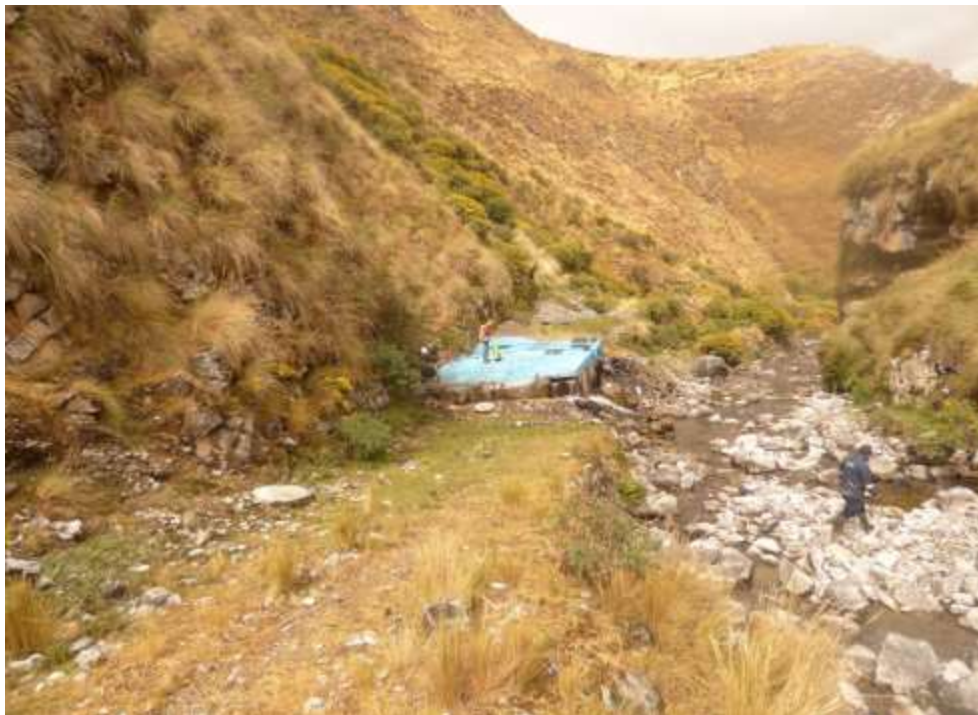
Fotografía 5.2. Río Chía, donde también se encuentra la captación del Ingenio, que abastece de agua potable al centro poblado de San Jerónimo de Tunan.
