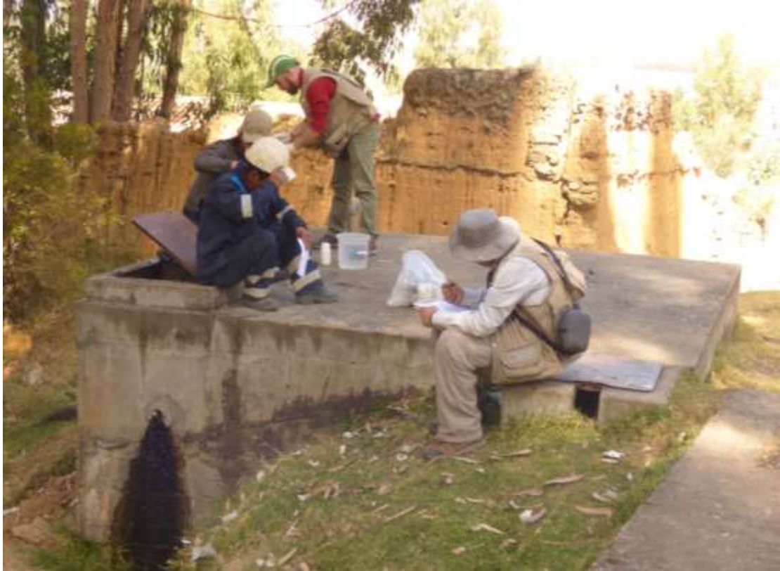
Fotografía 7.12 reservorio deteriorado por la salida de agua en el reboso.
