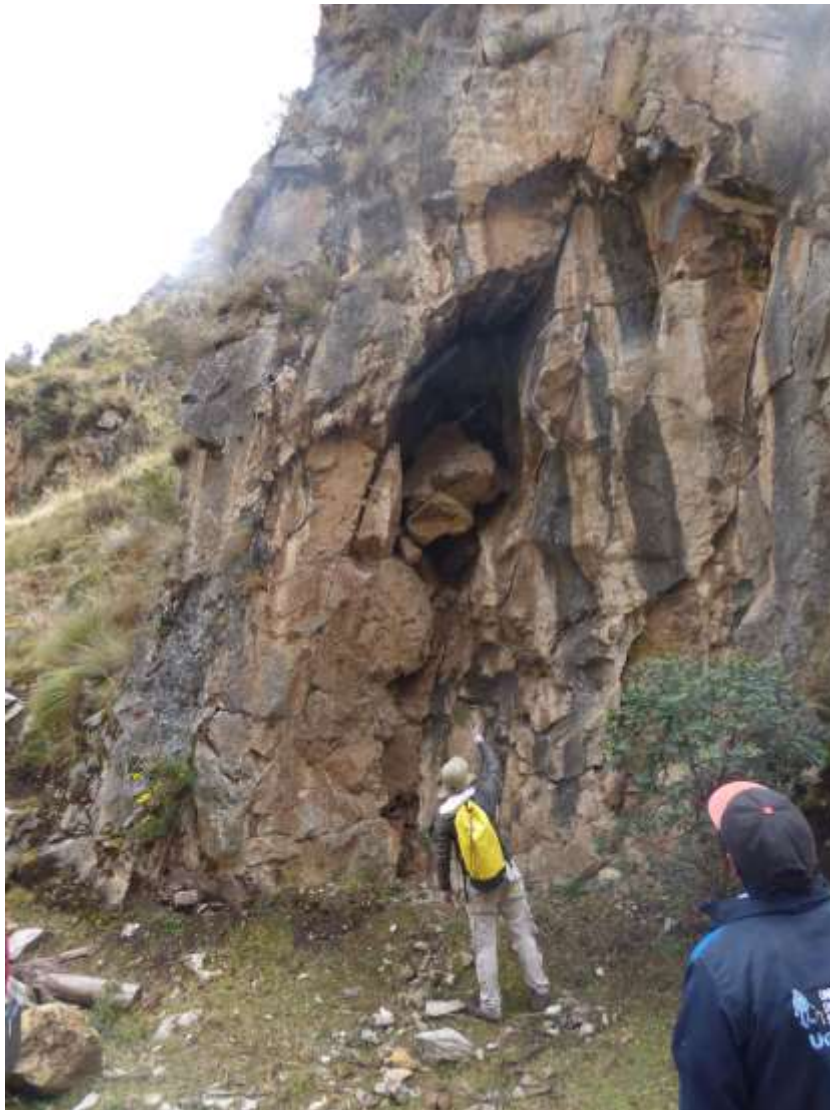
Fotografía 5.1. Sector de Ingenio, nótese los rastros de infiltración en las fracturas de las rocas.
