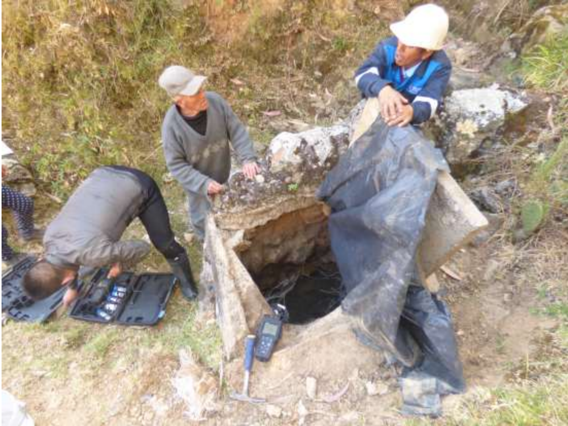
Fotografía 7.10 Manantial Alahuato, nótese la captación rustica con uso de plástico y tapa de cemento desgastado
