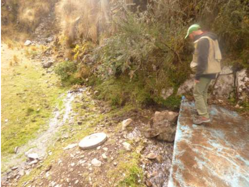
Fotografía 9.2. Producción de agua subterránea que sale al costado de la captación Ancall.
