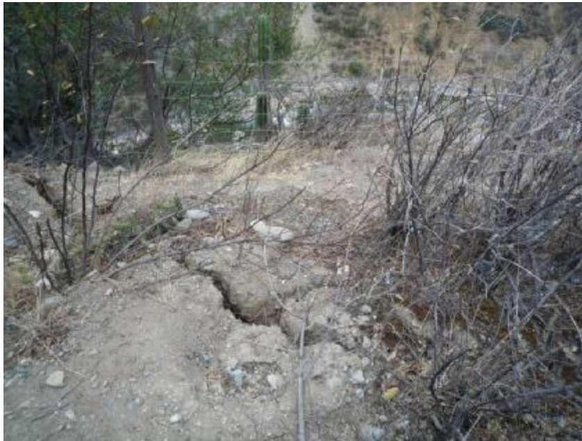
Foto 8. Otra grieta en el cuerpo del deslizamiento. Obsérvese el enrejado que ha sido colocado para impedir el avance del deslizamiento.
