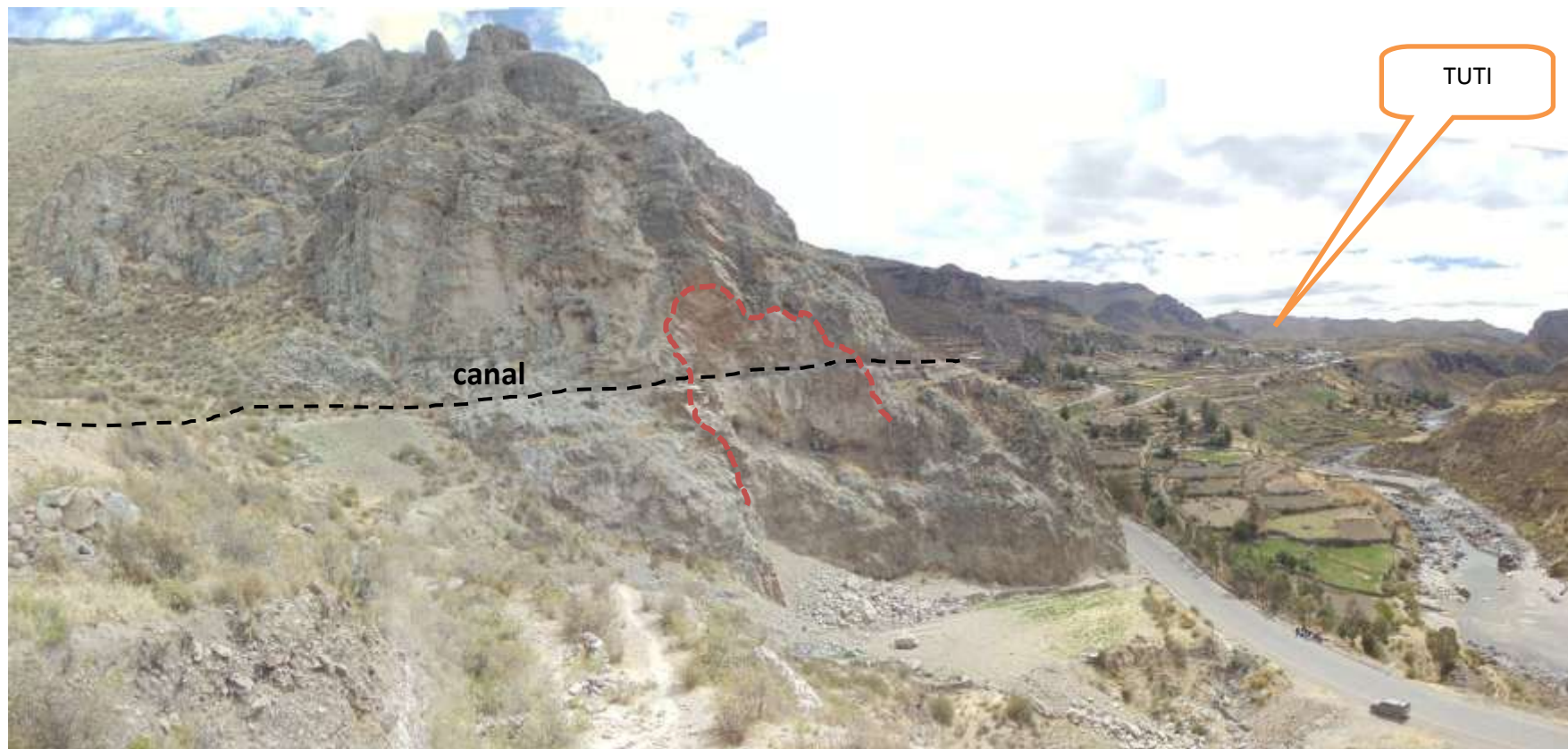
Foto 1. Valle del Colca visto aguas arriba donde se aprecia el poblado de Tuti, ubicado sobre una terraza aluvial y limitada por colinas y cerros de naturaleza volcánica. En rojo se resalta la zona del derrumbe ocurrido el 03/10/2011 que afectó canal de Tuti y causó cuatro muertos.
