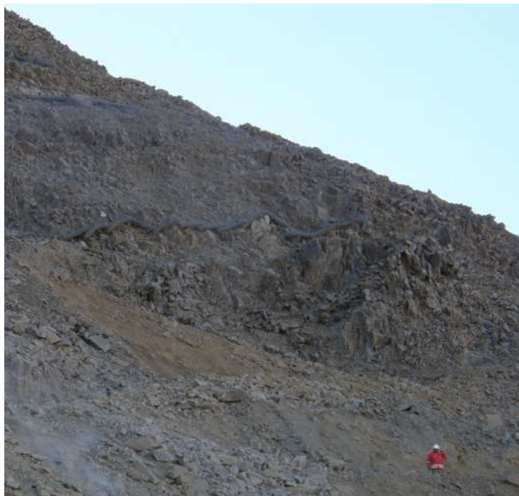
Foto 11. Trabajos de desquinche utilizando paralelamente protección con enmallado en taludes inestables.
