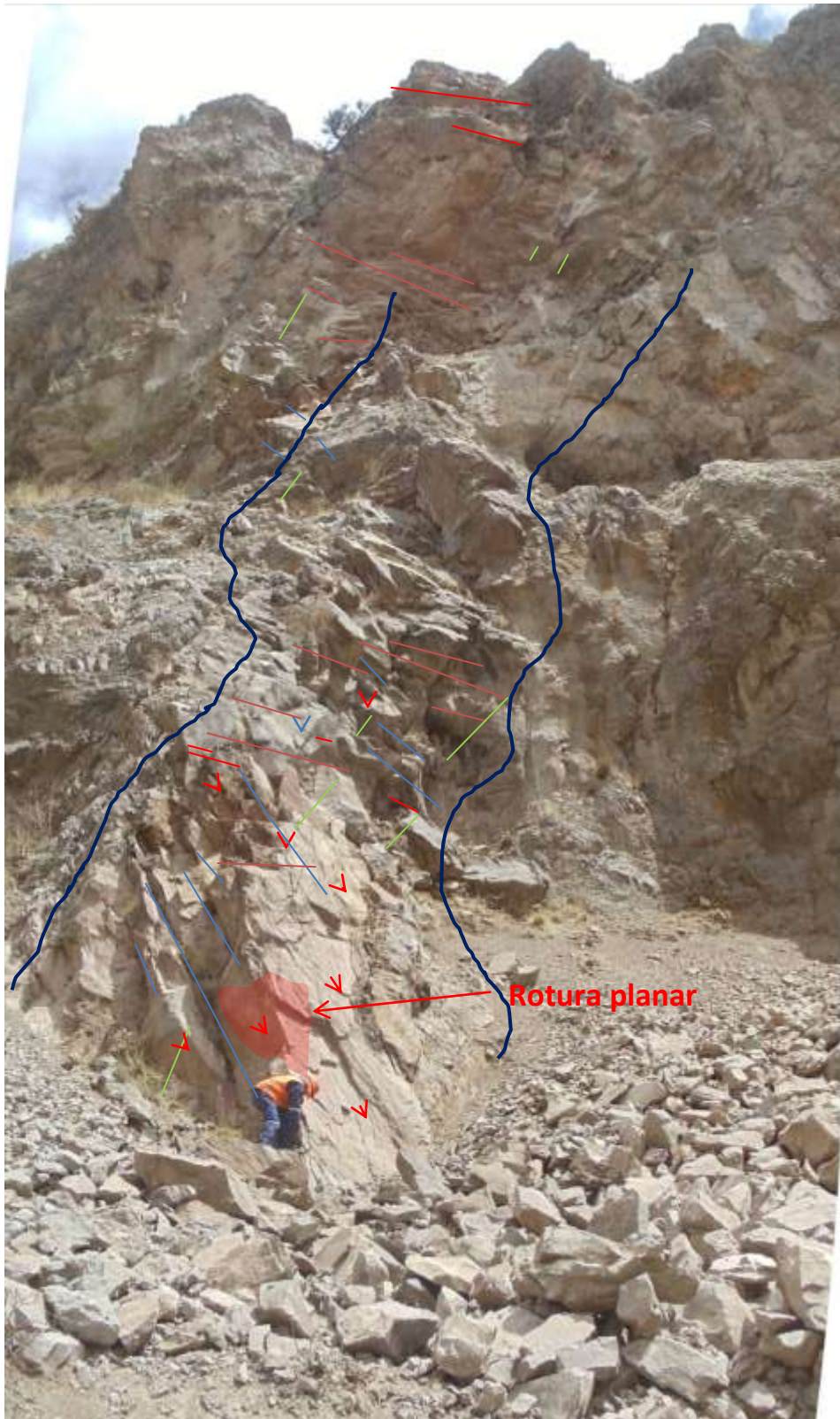
Foto 4. Detalle del dique intrusivo muy fracturado, en comparación a la roca encajonante. Se detallan en líneas de diferentes colores cuatro planos de fracturamiento principales, que originan bloques, los cuales se desprendieron con el derrumbe.
