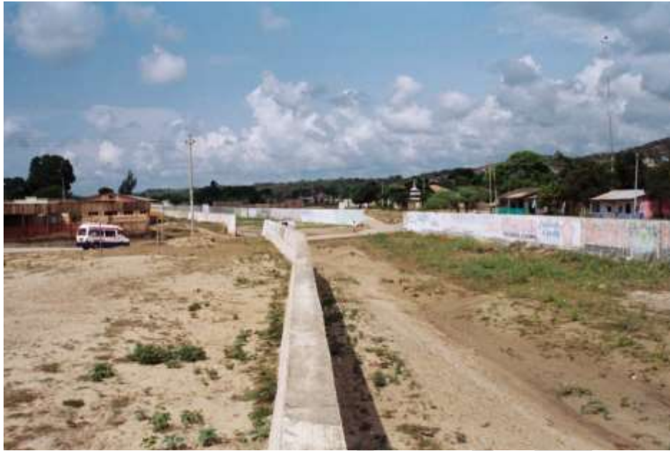
Fotografía 9.3. Flujo de lodo que pasa por la quebrada San Juan, distrito de San Juan de la Virgen. Se presenta generalmente con el Fenómeno de El Niño o con lluvias de tipo excepcional. La quebrada se encuentra canalizada.
