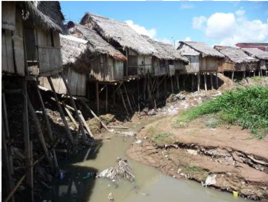
Fotografía 6.5. Barrio La Boca. Las viviendas para protegerse de la inundación están construidas sobre columnas de madera.
