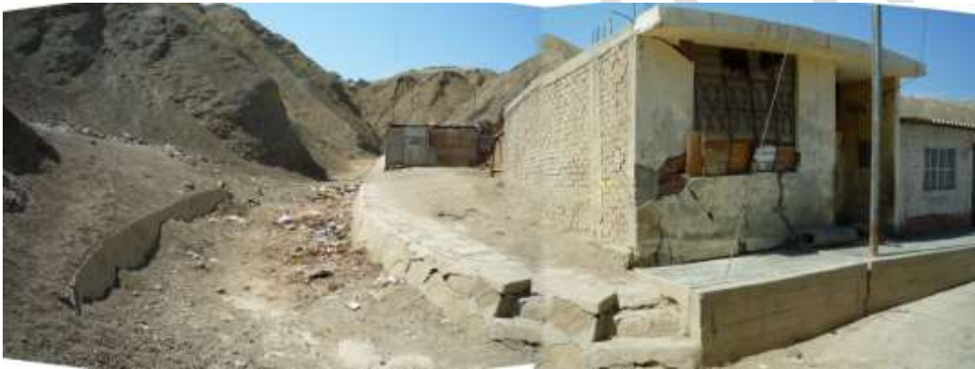
Fotografía 7.10. Torrenteras secas ubicadas a alrededores de Talara, las cuales se activan de manera excepcional, afectando viviendas (AA. HH. Luis Alva Castro) y pueden cortar tramo de la carretera Talara-Vichayal.
