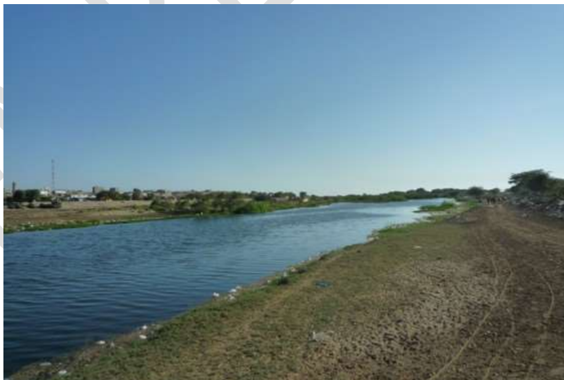
Fotografía 7.9. Vista de la amplia llanura de inundación del río Piura. Al lado izquierdo de la foto se observa viviendas del distrito de Sechura.
