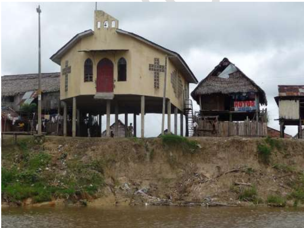
Fotografía 6.9. Nuevo Versalles, sector afectado por la inundación, se observa la construcción de vías de acceso en base a madera (Fotografía: Jorge Noriega).
