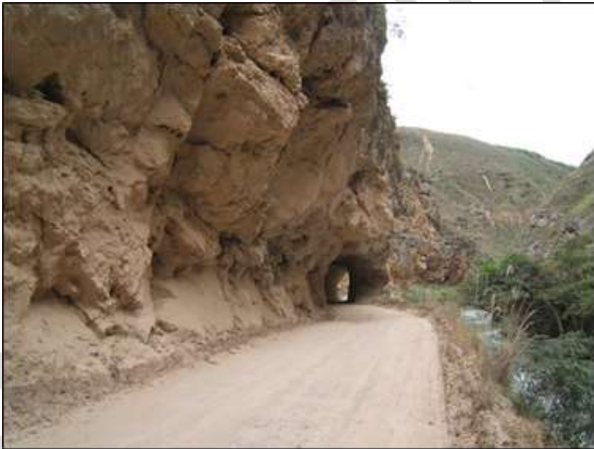
Fotografía 2.6. Sector El Túnel, margen derecha del río Utcubamba, se aprecia talud rocoso muy escarpado y ligeramente fracturado.
