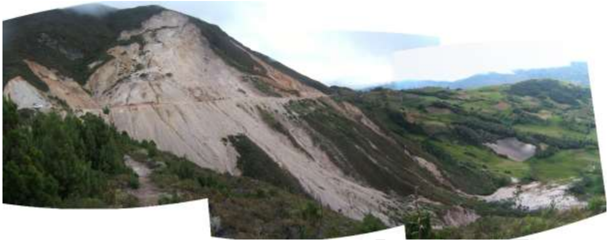
Fotografía 3.10. Sector de El Infiernillo, tramo de carretera Cutervo-Chiple-Jaén, afectada periódicamente por derrumbes. Zona explotada artesanalmente como cantera de material de construcción.
