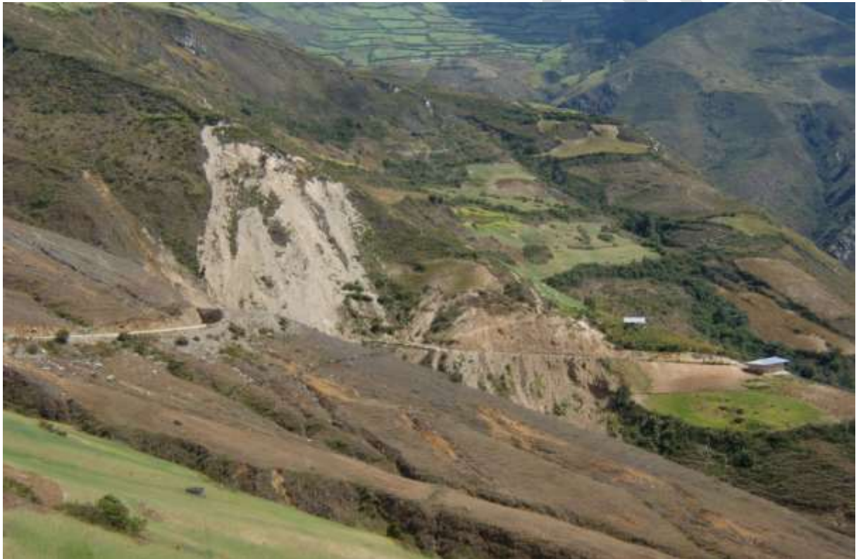
Fotografía 3.6. Deslizamiento traslacional que afecta tramo de la carretera de acceso a Chumuch.
