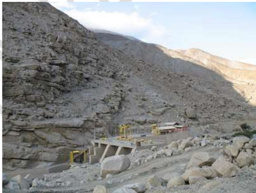
Fotografía 4.5. Vista de la Bocatoma Chavimochic. En los taludes del cerro se observa bloques de roca.
