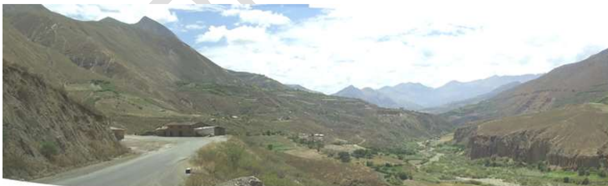
Fotografía 3.4. Vista panorámica de Huana Huana, carretera atraviesa un deslizamiento antiguo reactivado; pérdida de plataforma de carretera.
