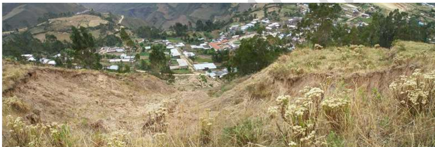
Fotografía 4.7. Escapa de deslizamiento activo en el sector de Uchumarca, provincia Bolívar.
