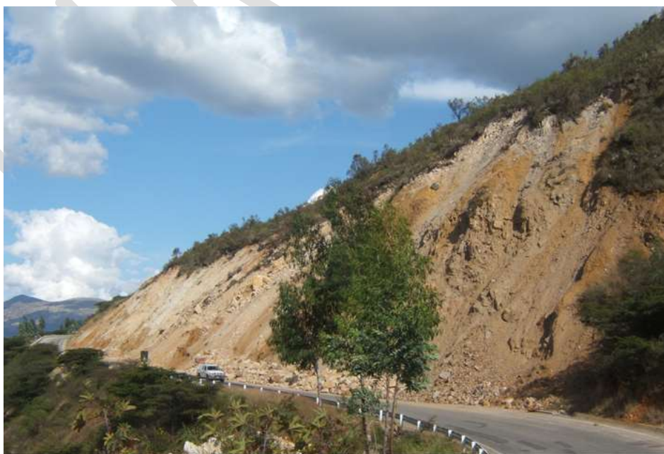
Fotografía 3.15. Sector de Chulucana, tramo de la carretera entre Cajamarca y San Marcos afectado por deslizamientos y derrumbes en los taludes de corte.
