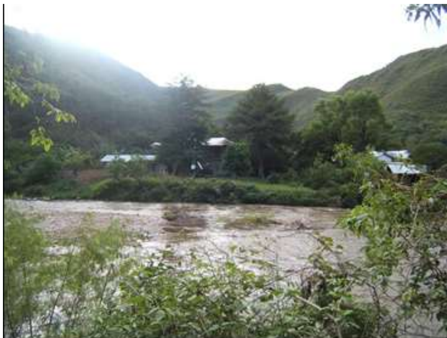
Fotografía 2.8. Intersección del río Mangalpa y Utcubamba, sector Nogalcucho, área susceptible a inundaciones y flujos de detritos.
