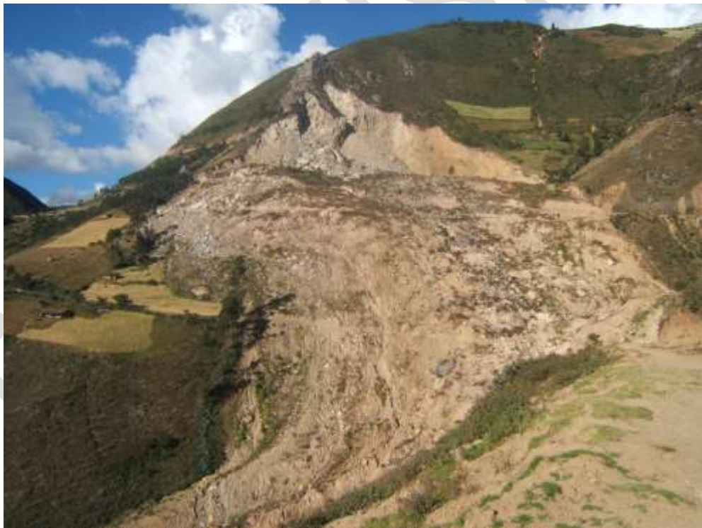
Fotografía 5.5. Sector afectado por deslizamiento rotacional reactivado como derrumbe-flujo (Tallapampa-Incahuasi).
