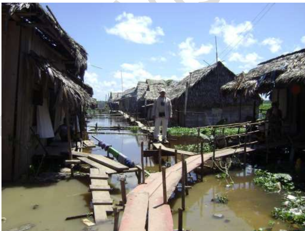
Fotografía 6.10. Embarcadero Pebas. Sector susceptible a inundaciones. Las viviendas para protegerse de la inundación están construidas sobre columnas de madera.
