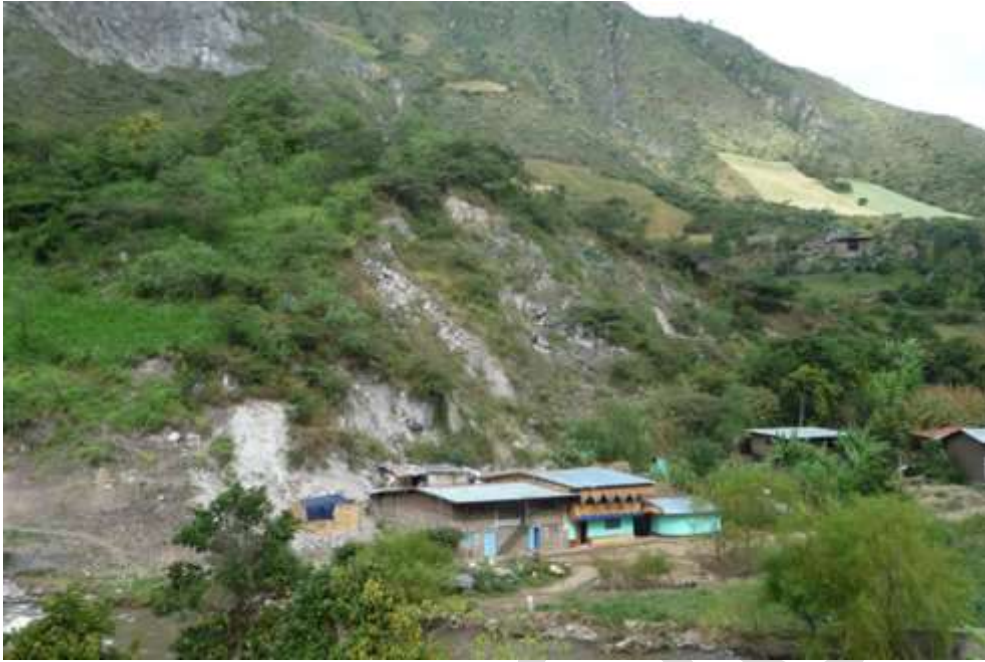
Fotografía 7.4. Caída de rocas en el sector de la Perla-Huancabamba.
