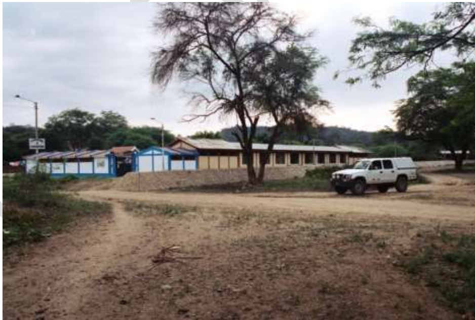
Fotografía 9.4. Quebrada Higuierón, canalizada con gaviones. Cada vez que se presenta el Fenómeno de El Niño se activa y afecta a las viviendas y terrenos de cultivo adyacentes.
