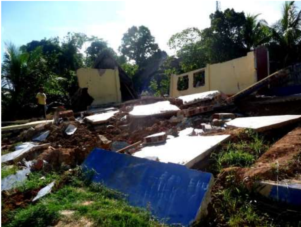
Fotografía 6.2. Calles Mariscal Castilla afectado por deslizamiento.
