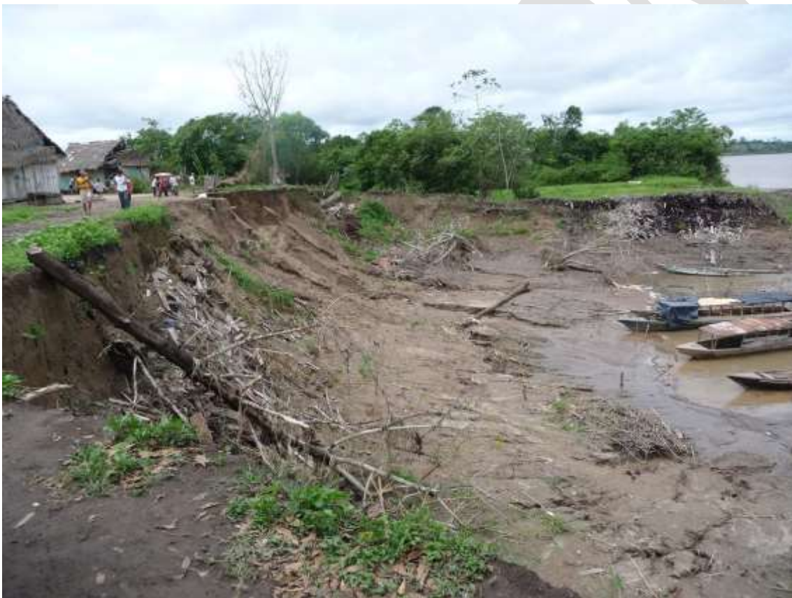
Fotografía 6.1. Sector Roaboya, vista de erosión fluvial que afecta al caserío.
