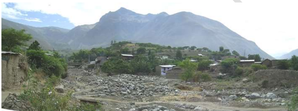
Fotografía 3.3. Km. 129+000 de la carretera a Cajamarca, deslizamientos activos producen la pérdida de terrenos de cultivo y carretera.
