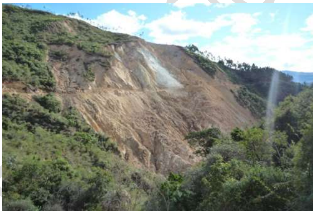
Fotografía 7.3. Derrumbes, asentamientos y derrumbe-flujo de detritos, en la carretera Ayabaca-Espíndola, impiden el tránsito de vehículos.
