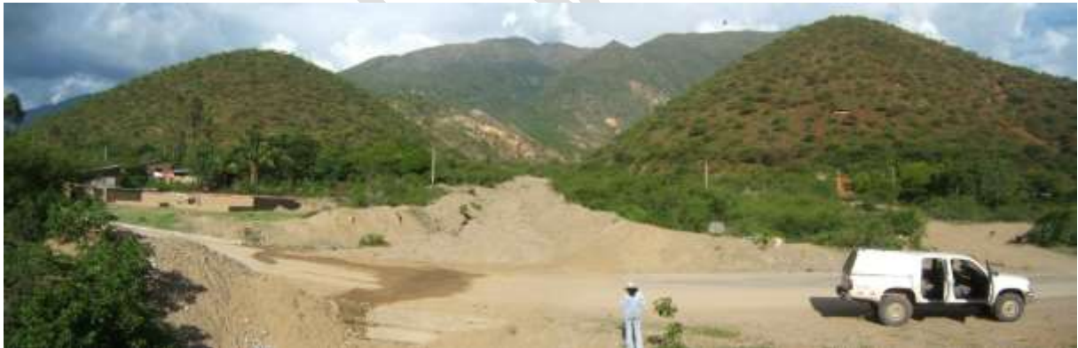
Fotografía 3.13. Áreas susceptibles a huaicos periódicos a ocasionales; erosión en cabecera de cuencas alimentan flujos de detritos que afectan tres tramos de la carretera a Pomahuaca.
