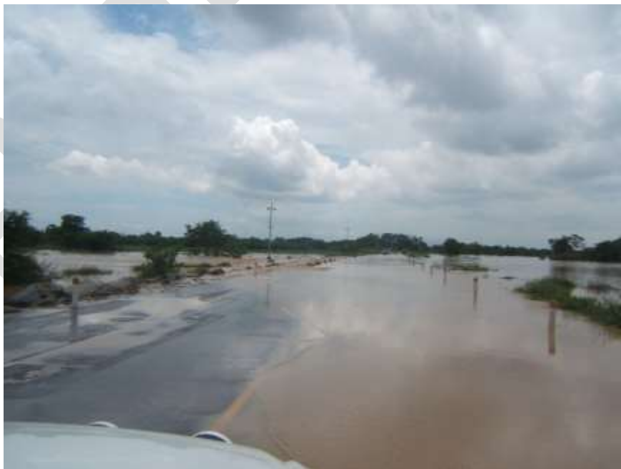
Fotografía 5.6. Vista de un área inundada por el desborde del río La Leche, entre Machuca y La Cirila (Pacora, Lambayeque).
