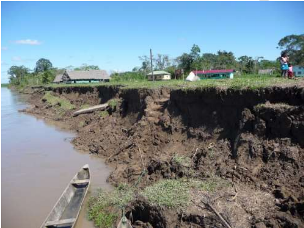
Fotografía 6.4. Bolívar, el área es susceptible a erosión fluvial e inundaciones.
