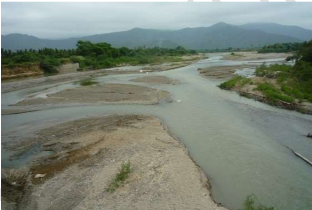
Fotografía 7.6. Puente Salitral, se observa el valle amplio, con procesos de erosión en ambas márgenes.
