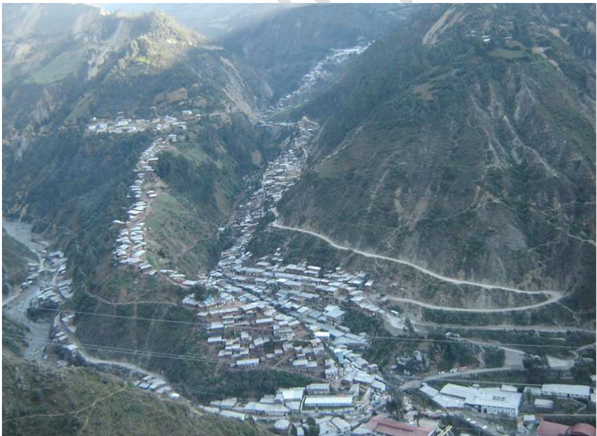
Fotografía 4.9. Vista panorámica de los sectores de Parcoy y Retamas (centro minero). Área susceptible a la ocurrencia de flujos y derrumbes. Las viviendas se encuentran construidas dentro del cauce de la quebrada Patacocha.
