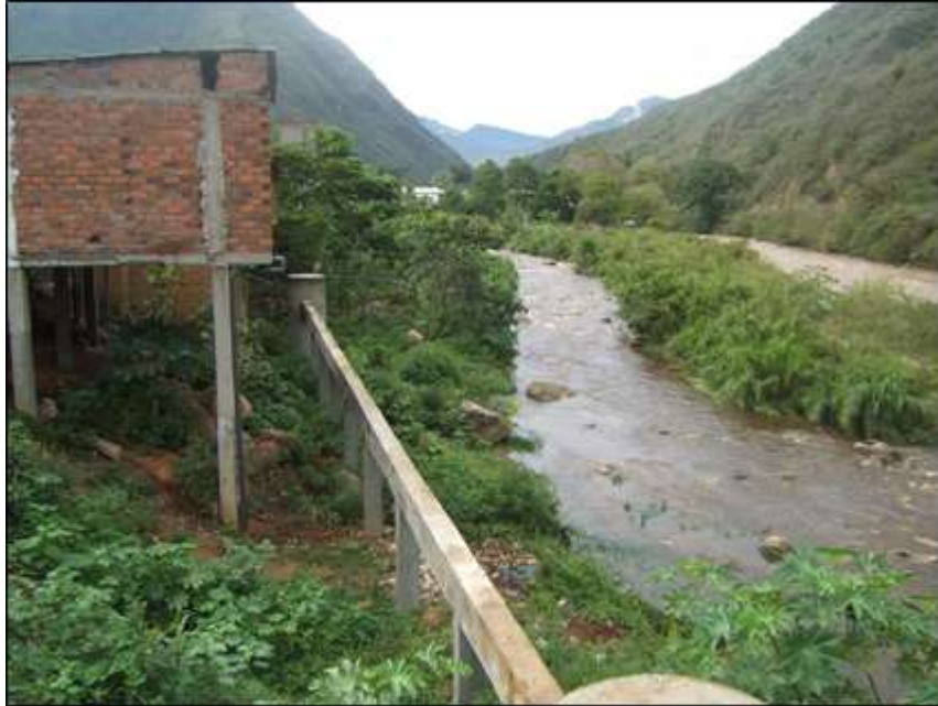
Fotografía 2.3. Pedro Ruiz, ocurrencia de erosión fluvial en la margen derecha del río Utcubamba. También podría ser afectada por inundaciones.
