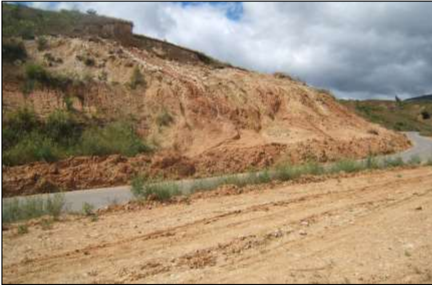
Fotografía 2.5. Deslizamiento – flujo, ubicado en la ruta de acceso a la ciudad de Chachapoyas, tramo desvío Leimebamba – Chachapoyas.
