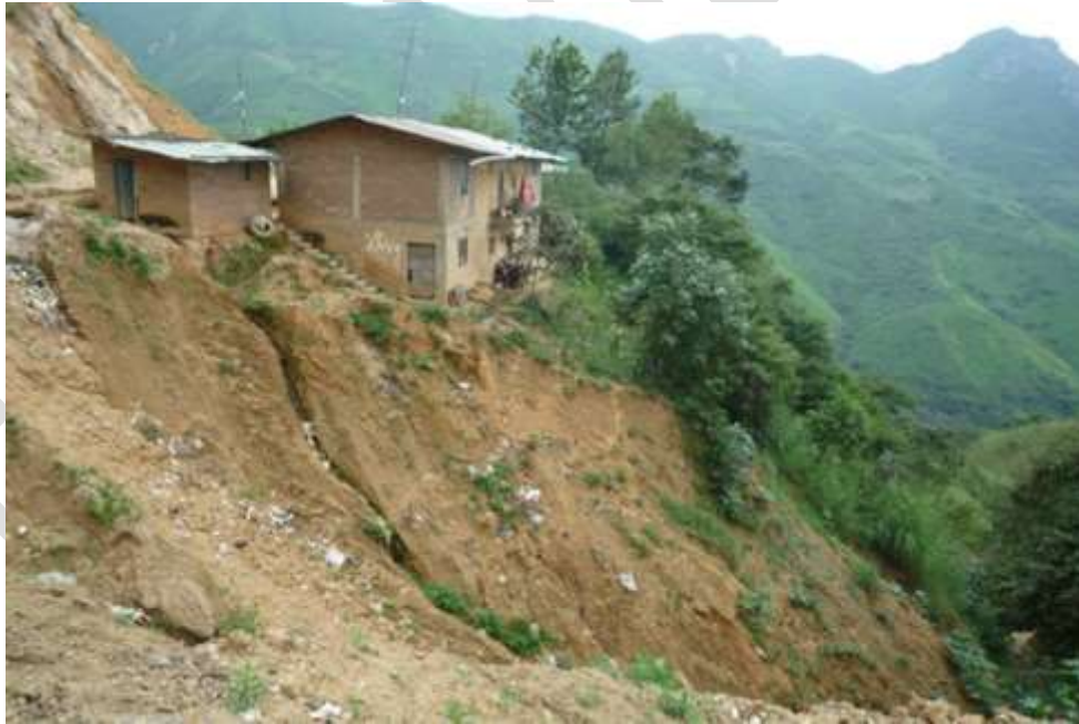
Fotografía 7.5. Viviendas del poblado de Higerón, comprometidas por deslizamientos activos.
