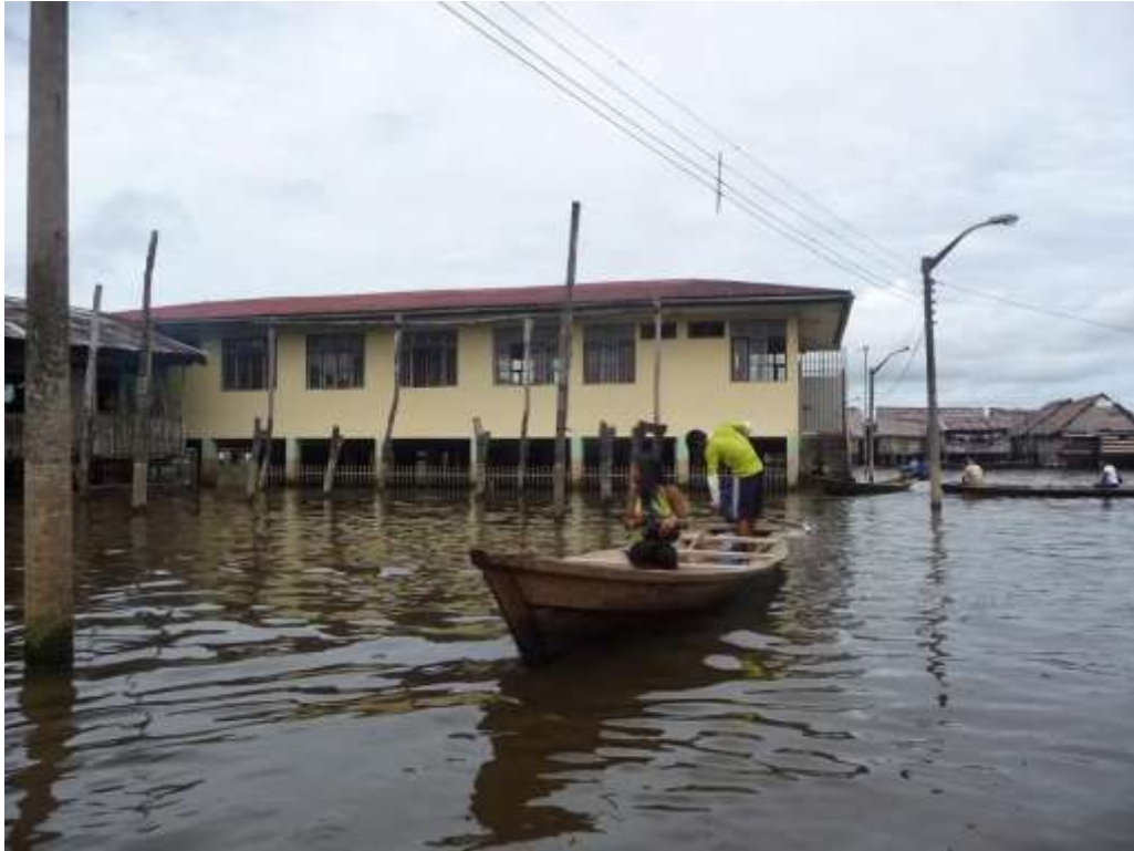
Fotografía 6.8. Sachacoro, sector afectado por la inundación fluvial. Fotografía tomada en junio 2009.
