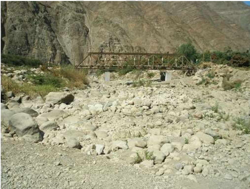
Fotografía 4.2. Área susceptible a inundaciones y erosión fluvial, confluencia del río Cascas y Chicama. Se observa depósitos aluviales y fluviales compuestos por bloques de roca.
