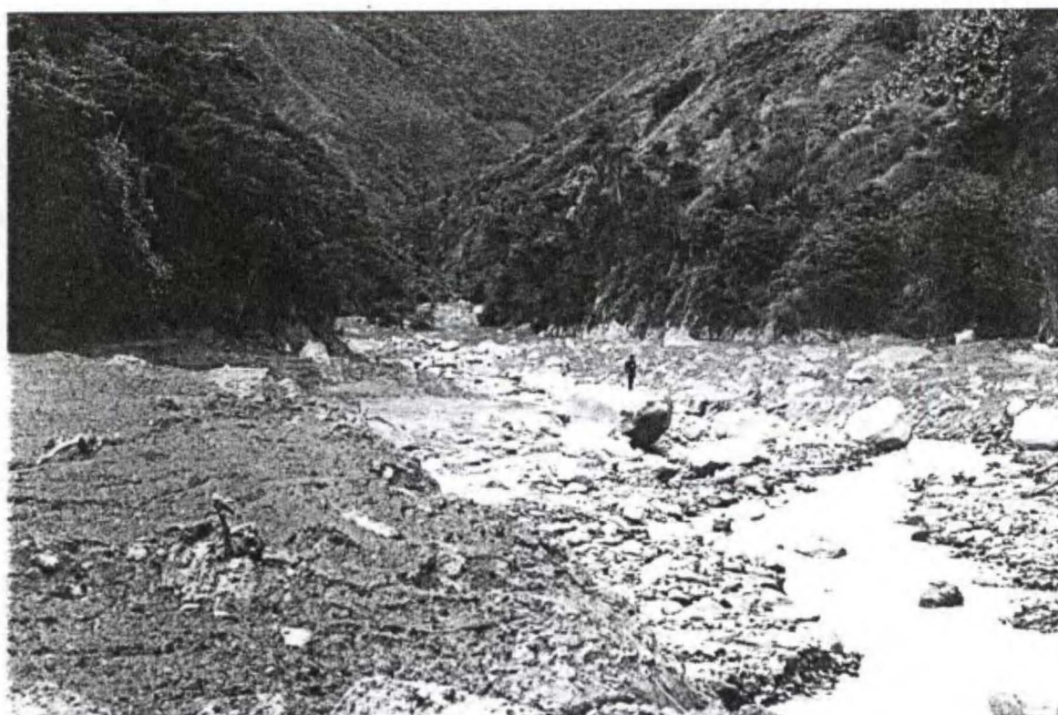
FOTO N° 8. Viviendas, animales y terrenos de cultivo arrasados y cubiertos de lodo por el aluvión.
