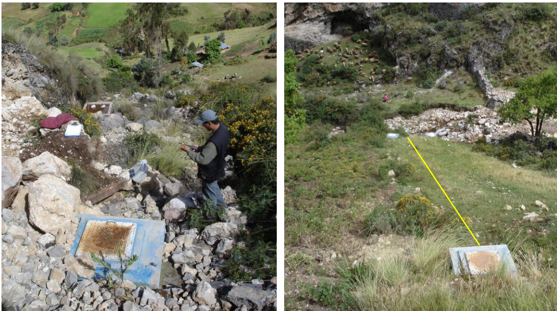
Figura 10. Izquierda: Captación Llamellín, sistemas de captación directa de manantiales de ladera. Derecha: Captación Huayllagra, obsérvese el alineamiento de las surgencias
