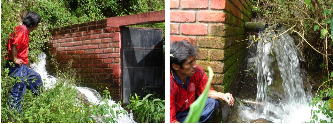
Figura 7. Sistema de captación directa del manantial Uchco, usado para consumo humano de la población de Mirgas
