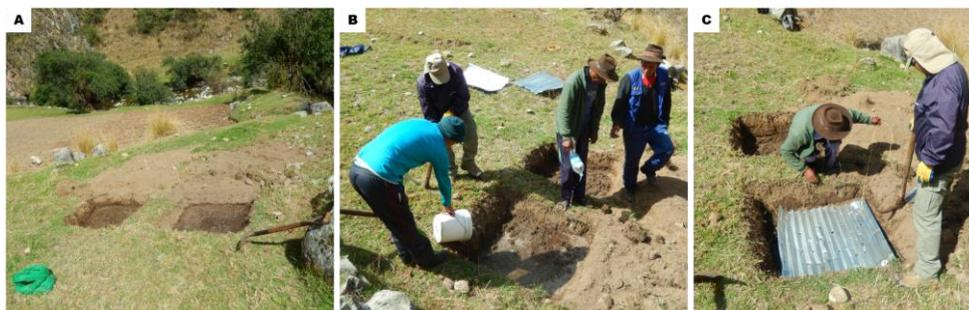
Fig. 7.4. Preparación e instalación del punto infinito
