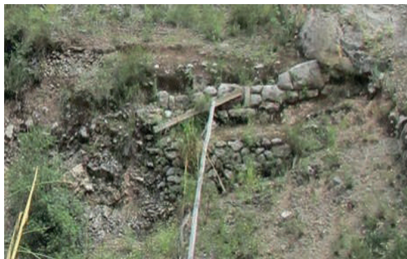
Foto 1. Mantenimiento deficiente del sitio arqueológico Llaullipata.
