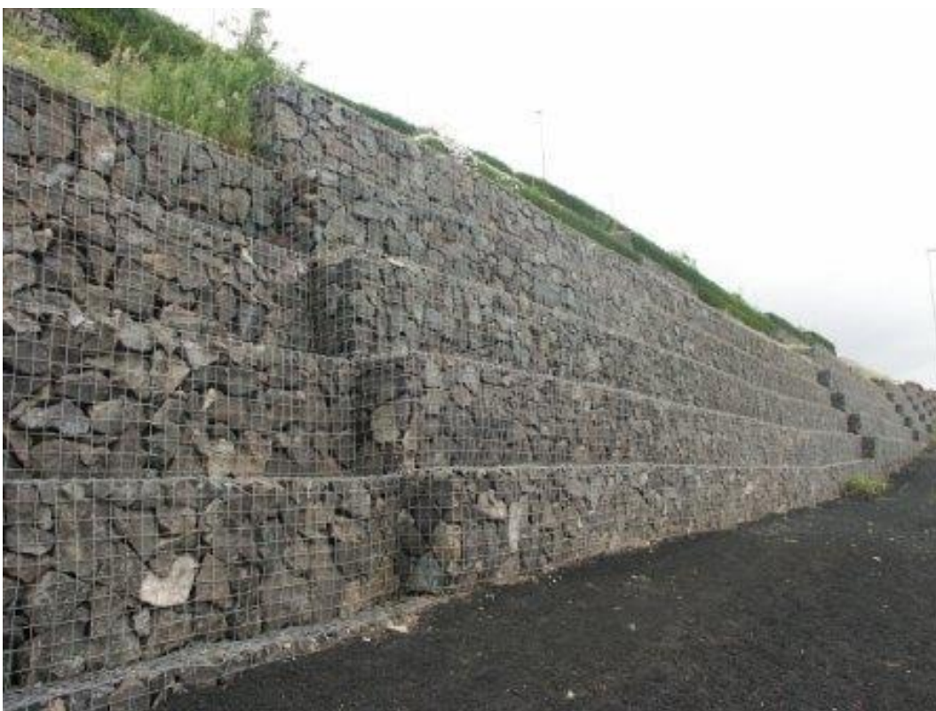
Foto 7. Defensa ribereña con muro de gaviones en gradería.
