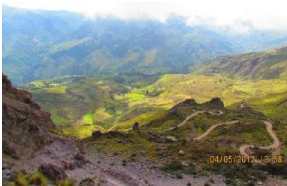
Foto 8. Vista panorámica del deslizamiento de Aurahuá.
