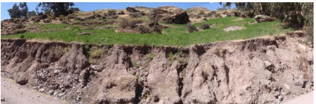
Foto 11. Se aprecia los bloques de rocas esparcidos en la superficie. El corte de talud se muestra erosionado.
