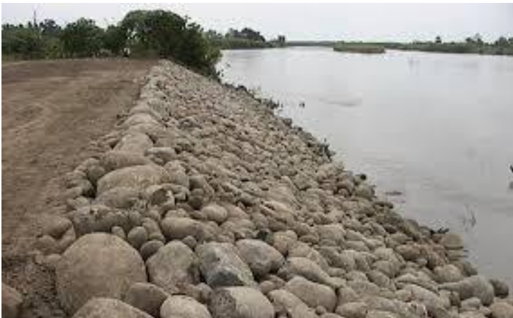
Foto 6. Defensa ribereña con enrocado de la ribera de río.
