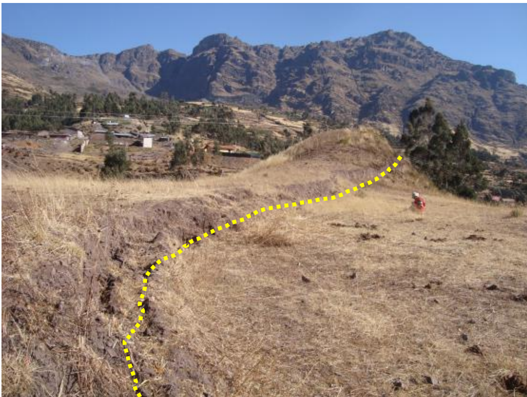
Foto 5. Agrietamiento con dirección NO, cerca del cementerio, con un salto de hasta 1m.
