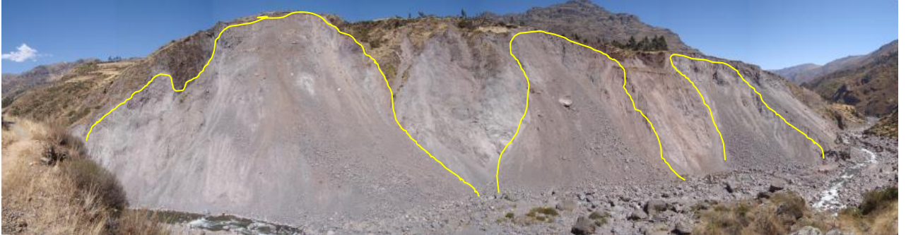
Foto 9. Derrumbes en la margen izquierda del río Aurahuá
