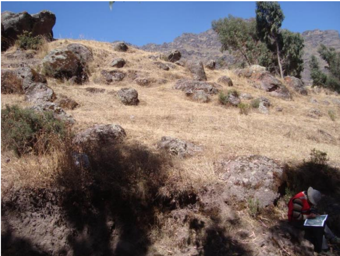
Foto 10. Bloques de rocas esparcidos en el cuerpo del deslizamiento antiguo.
