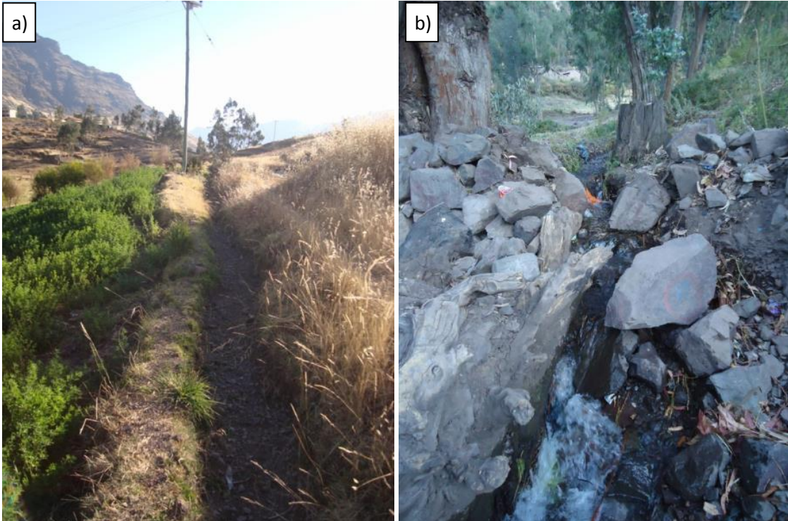
Foto 1. a) Canal de regadío sin recubrimiento impermeabilizante. b) Canal de abastecimiento de agua con un caudal permanente, sin canalización adecuada y revestimiento.
