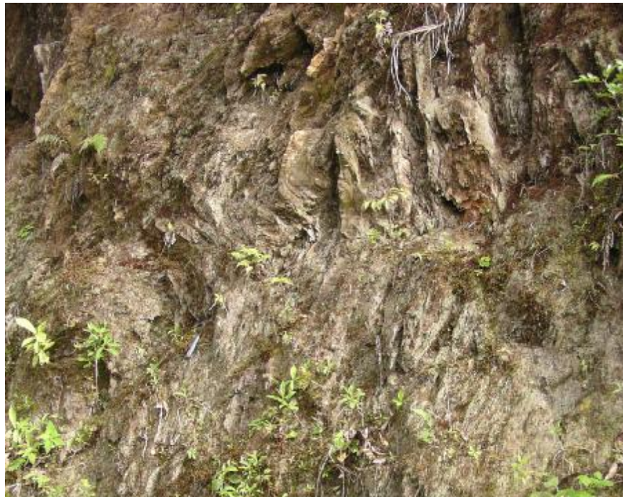
Foto No. 1. Esquistos meteorizados (UTM:703822-9478922), afectados por fuerte deformación dúctil (S de Palanda, camino Palanda-Los Entierros).
