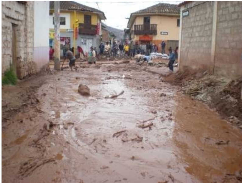
Foto 47: Avenida 9 de diciembre inundada por flujo de detritos y lodo.
