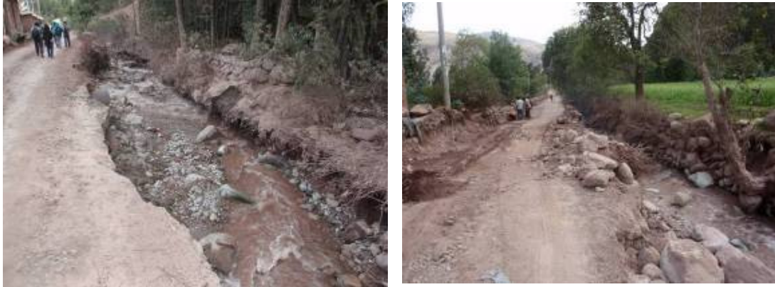
Fotos 35 y 36: Estrechamiento del canal del río (izquierda) y de la canalización inca (derecha) por ampliación de la carretera- En ambos casos hay erosión y desborde de flujo de detritos (aluvión del 17 de Octubre del 2010).
