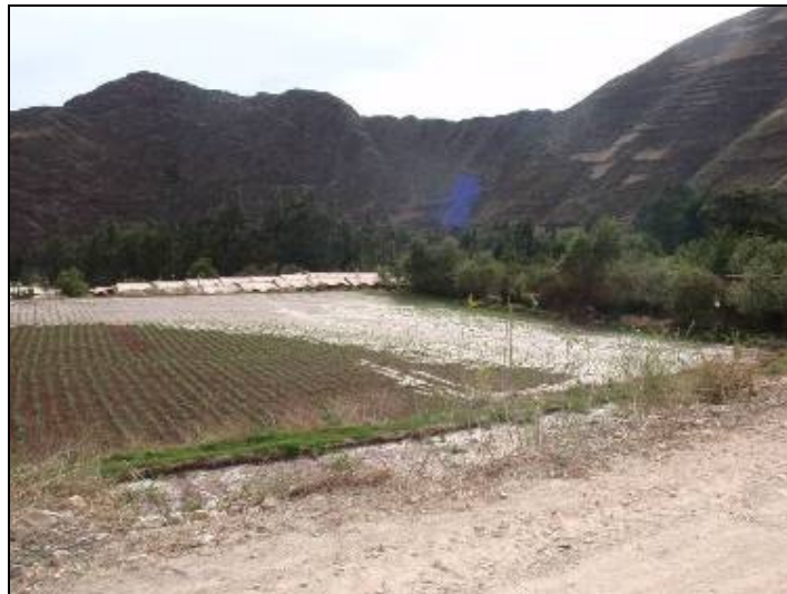
Foto 37: Desborde del flujo de lodo (aluvión del 17 de octubre del 2010) que afectó un condominio en la quebrada Chicón.
