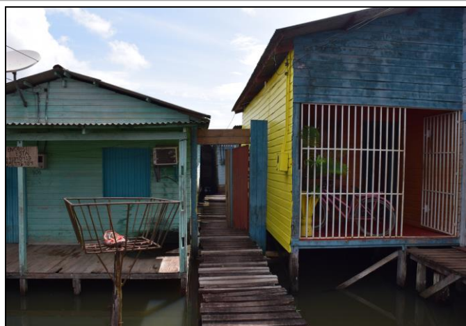
Figura 3. Habitação em área de ressaca em Macapá – bairro Novo Buritizal
