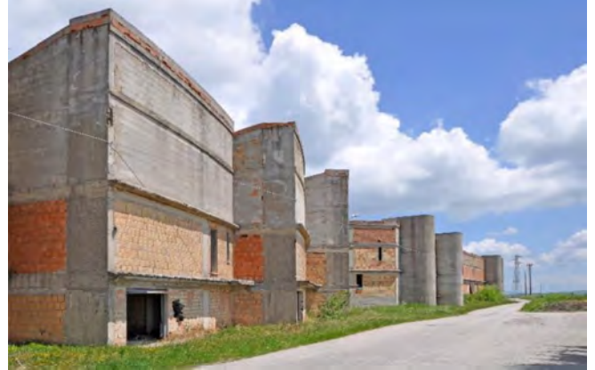
Fig. 5 - L'incompiuta cinta edilizia del rione Boscozzulo, prima della demolizione. (fonte: archivio degli autori, 2017)
