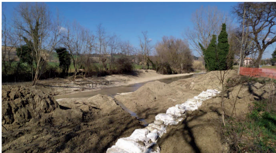
Fig. 3 - Lavori di sistemazione degli argini del fiume per la riduzione del rischio idraulico. Fonte: Foto di Federica Appiotti
