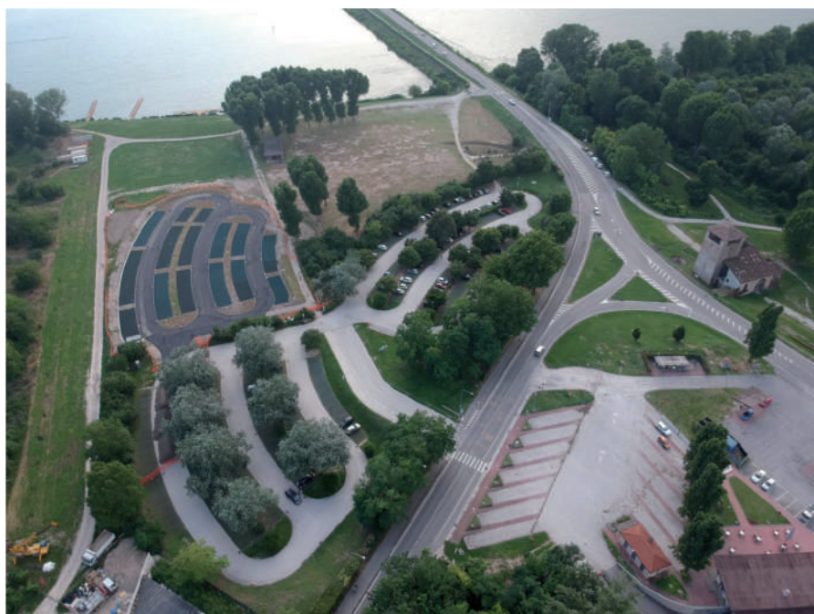
Fig. 2 - Vista del parcheggio di Campo Canoa sulla sponda sinistra del Lago di Mezzo. Fonte: Comune di Mantova
