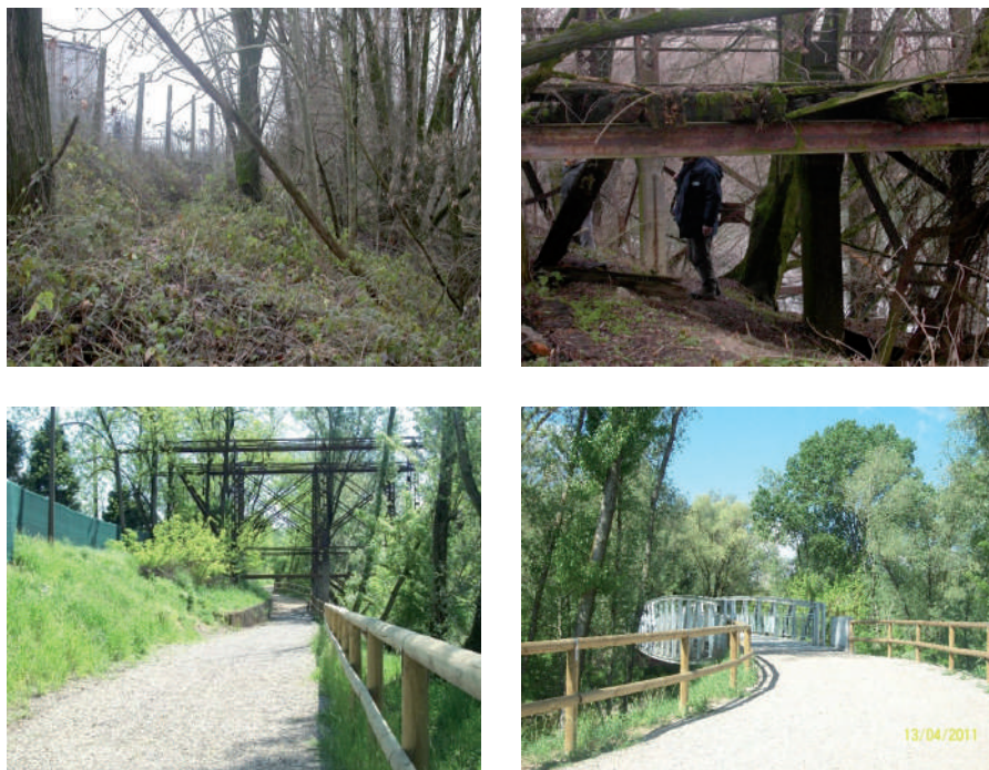
Fig 1 - Il Parco periurbano dei Laghi di Mantova: riva sinistra lago di Mezzo, prima e dopo gli interventi di riqualificazione. Fonte: Comune di Mantova
