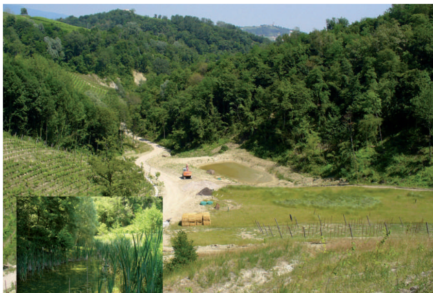
Fig. 1 - Refrontolo: bacino di accumulo in fase di realizzazione (2013) e situazione a luglio 2019
