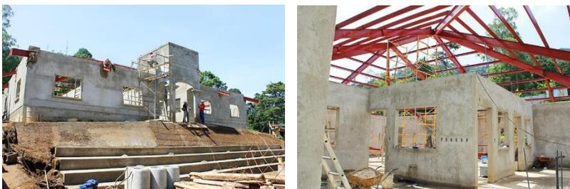
Fig. 71. Distintas fases de la construcción del proyecto en las que se puede observar de mejor manera los materiales de construcción utilizados. Fuente: <https://bit.ly/43j4Fkn> y <https://bit.ly/3D2jZXM>
