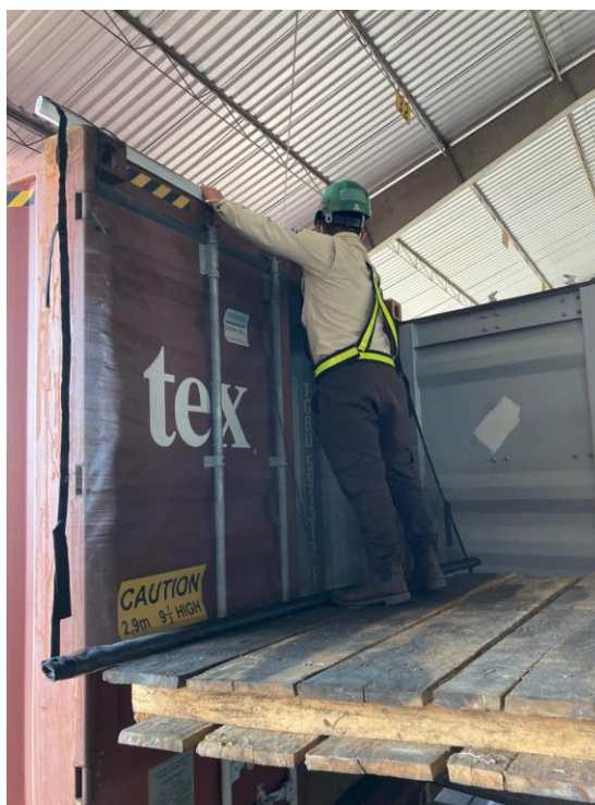
Implementación de la malla de contención al momento de aperturar los contenedores.
