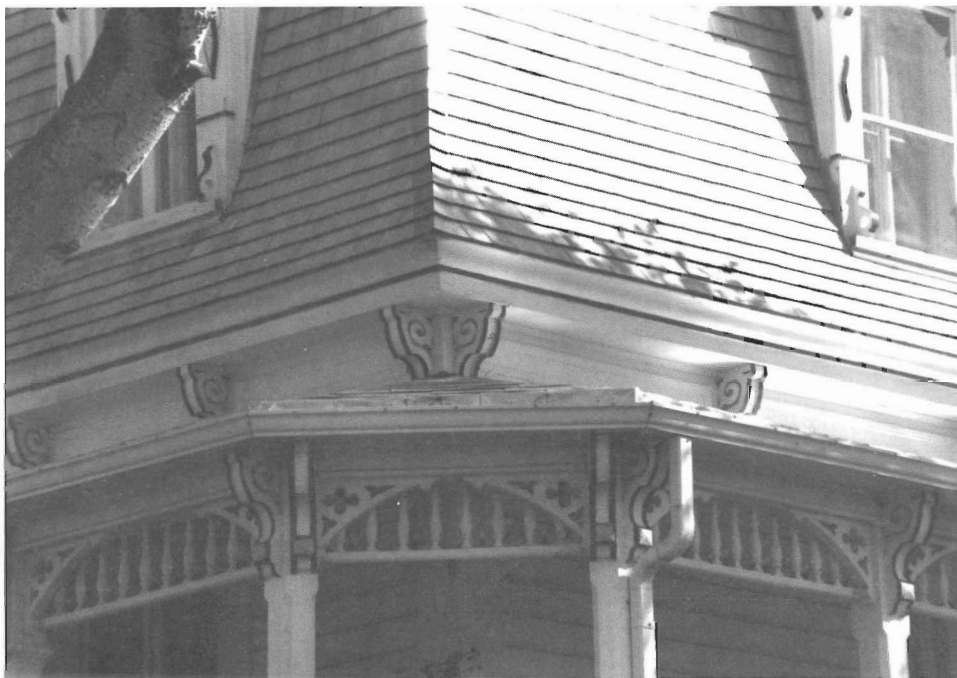
Détails de l'ornementation : Consols, lambrequins à balustres et appliqués de bois.
