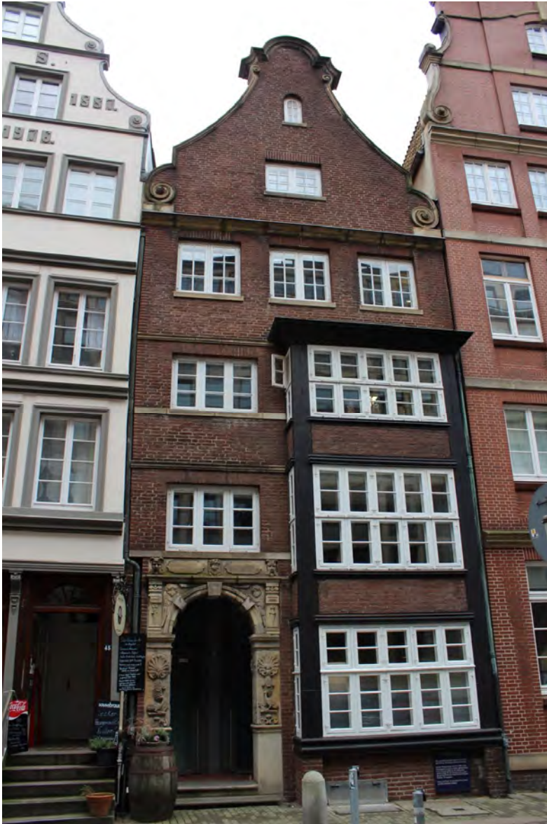
Abb. 4: Blick auf die historische Fassade des Hauses Deichstraße Nr. 47.
