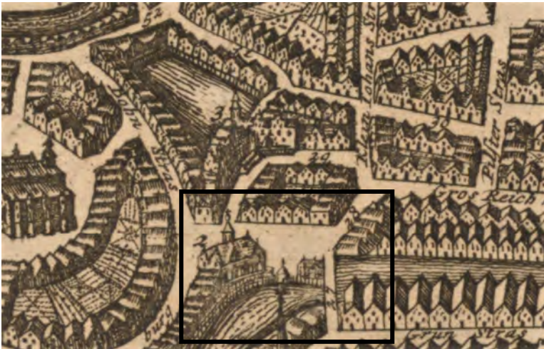
Abb. 19: Mutmaßlicher Standort von Wierings Druckerei in den Brod-schrangen (28) gegenüber dem alten Kran, der sich rechts neben dem Börsengebäude (2) befindet (Darstellung um 1686).
