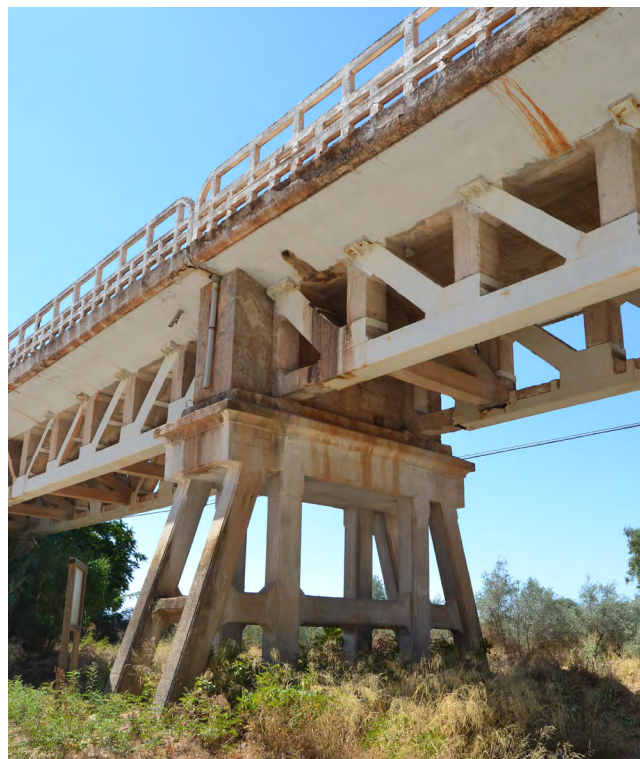
Figura 11. Palizadas de entramado de hormigón armado en el puente de Villanueva de la Reina sobre el Guadalquivir, construidas conforme al proyecto de 1917. Foto del autor.
