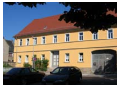
Straßenfront des sanierten Haupthauses
