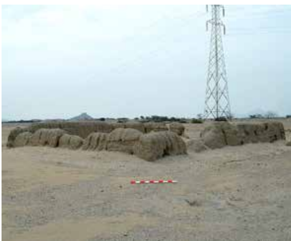
Figura 16 Ambientes construidos con muros de tapia
