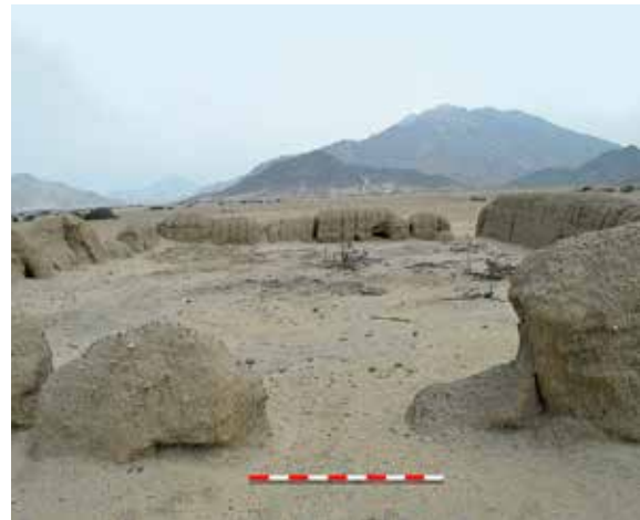
Figura 15 Ambientes construidos con muros de tapia
