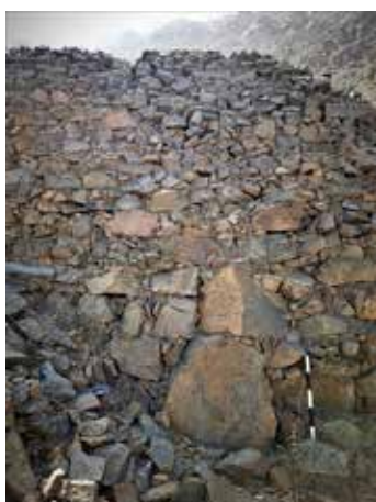
Figura 67 Detalle del aparejo irregular de las murallas en cerro El Sapo
