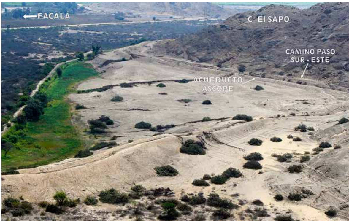
Figura 4 Vista general de un tramo de acueducto de Ascope
