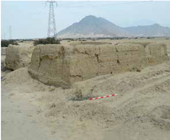
Figura 12 Ambientes construidos con muros de tapia
