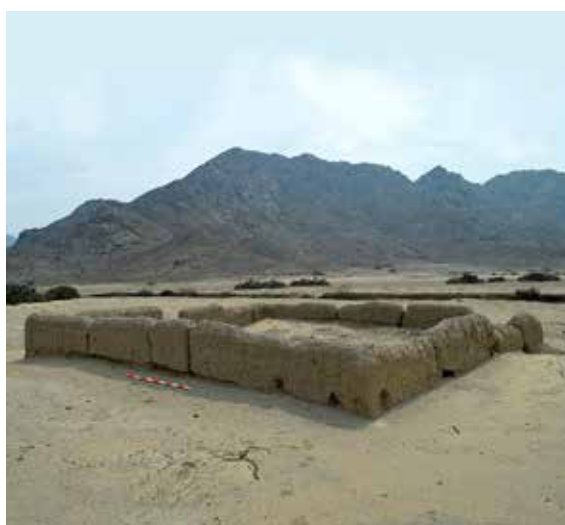
Figura 11 Ambientes construidos con muros de tapia
