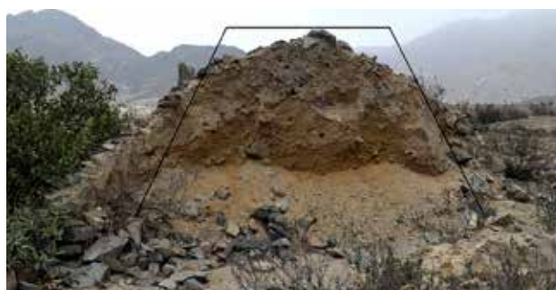
Figura 68 Muro encamisado por mampostería relleno por cascajo y gravilla
