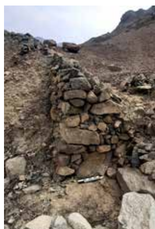
Figura 70 Muro relleno por piedras ubicado sobre la roca madre
