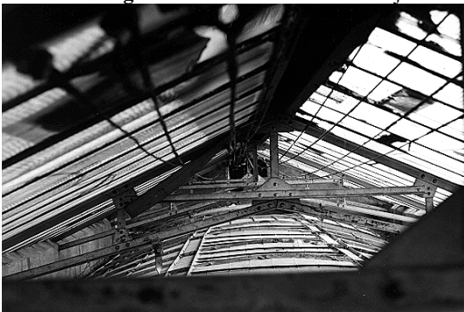
Figura 4. Vista interior de las protecciones exteriores de los vitrales. (Cielo claro con sol izq. y nublado derecha).
