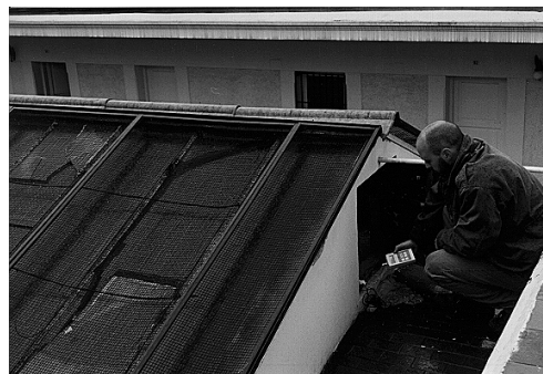
Figura 5. Mediciones de transmitancia del Sistema de protección (Cielo claro con sol izq. y nublado der.)
