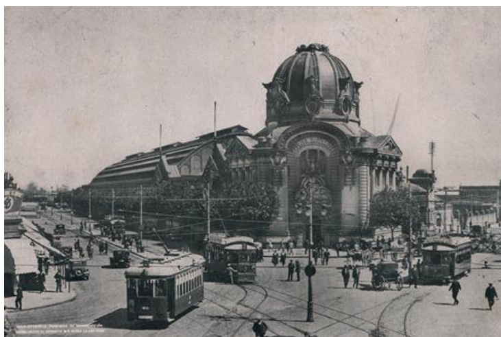
Fig. 3. Estación La Plata, aspecto original
