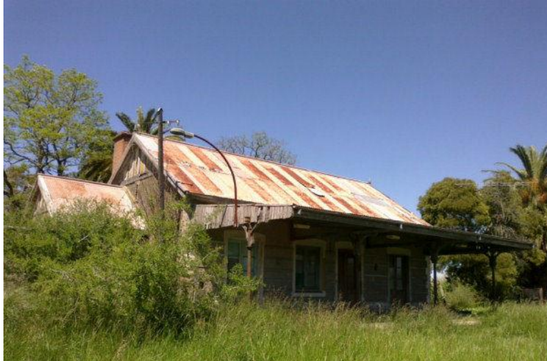
Figura 19. Estación Las Pipinas
