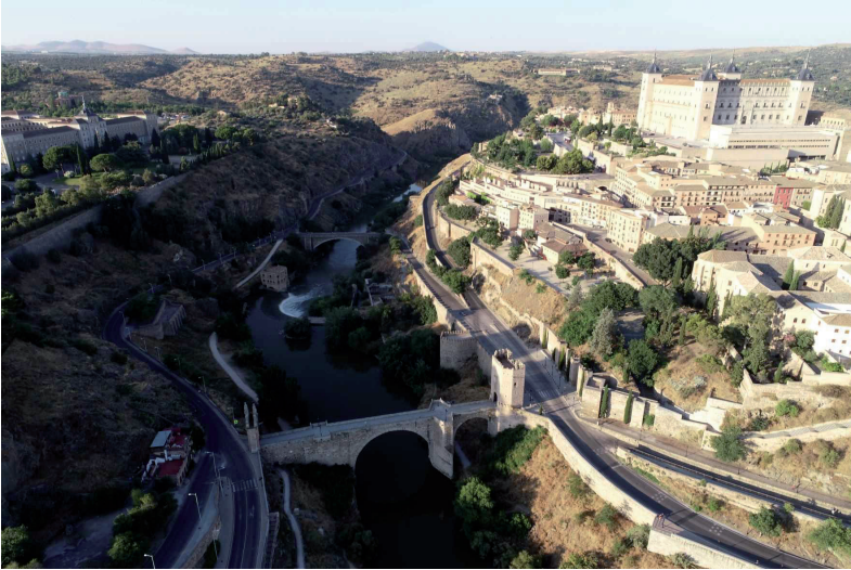
Fig. 5. Vista general de Toledo con la zona del puente de Alcántara. Foto: David Gallego Valle.
