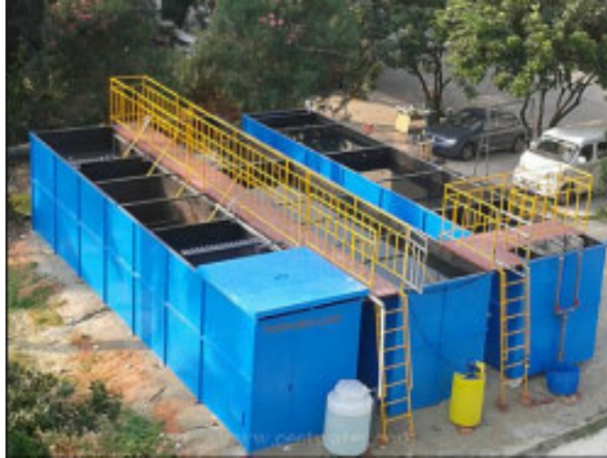
Figura 1: Ejemplo de planta de tratamiento con tecnología MBR Fuente: Tratamientos Específicos de vertidos industriales. García Román
