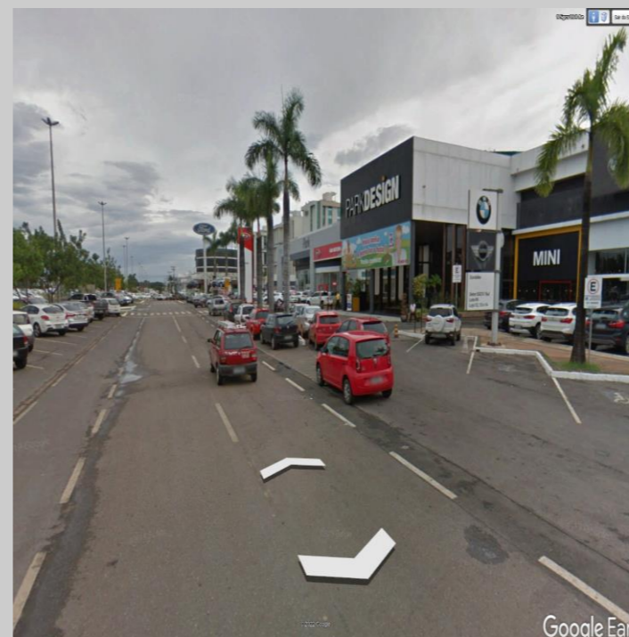
SGCV - Lotes voltados para EPIA Concessionárias de Veículos, Shopping, Comércio, Prestação de Serviços - 2022 Fonte: Google Earth
