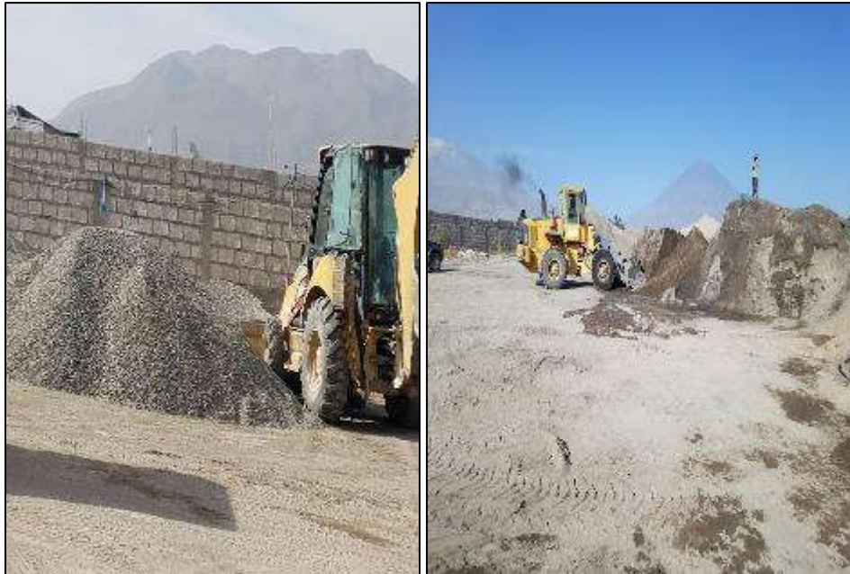
Figura 03: Canteras 48 Fuente: Elaboración propia
