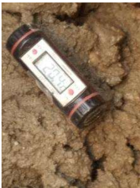
FIGURA 20 Toma de temperatura al concreto
