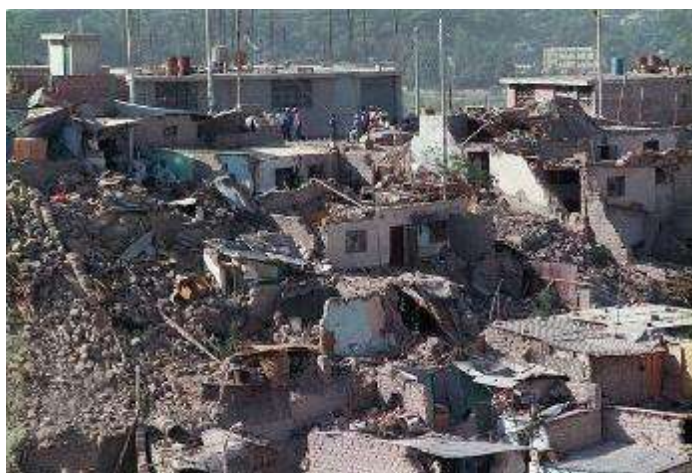
FIGURA 3 Casas destruidas por terremoto
