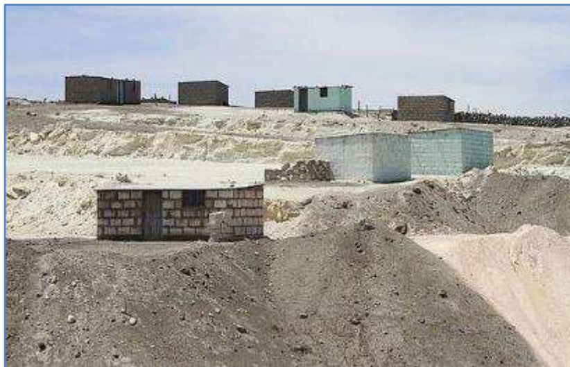
FIGURA 1 Construcción de viviendas en zonas de riesgo en el pueblo joven Apipa en el distrito de Cerro Colorado de la ciudad de Arequipa
