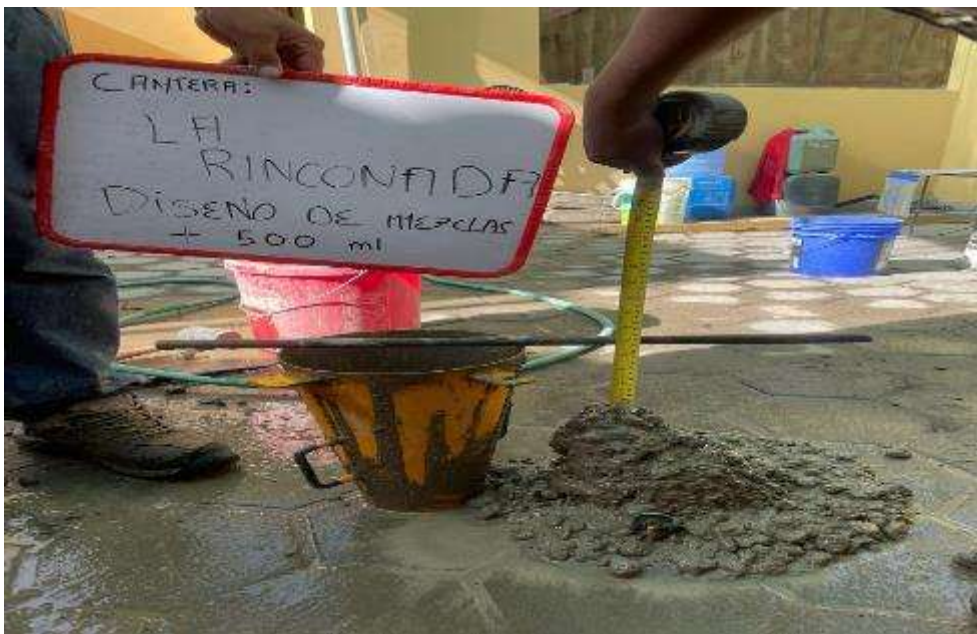
Figura 40: Asentamiento y/o slump con aditivo al máximo (Cantera la Rinconada) Fuente: Elaboración propia
