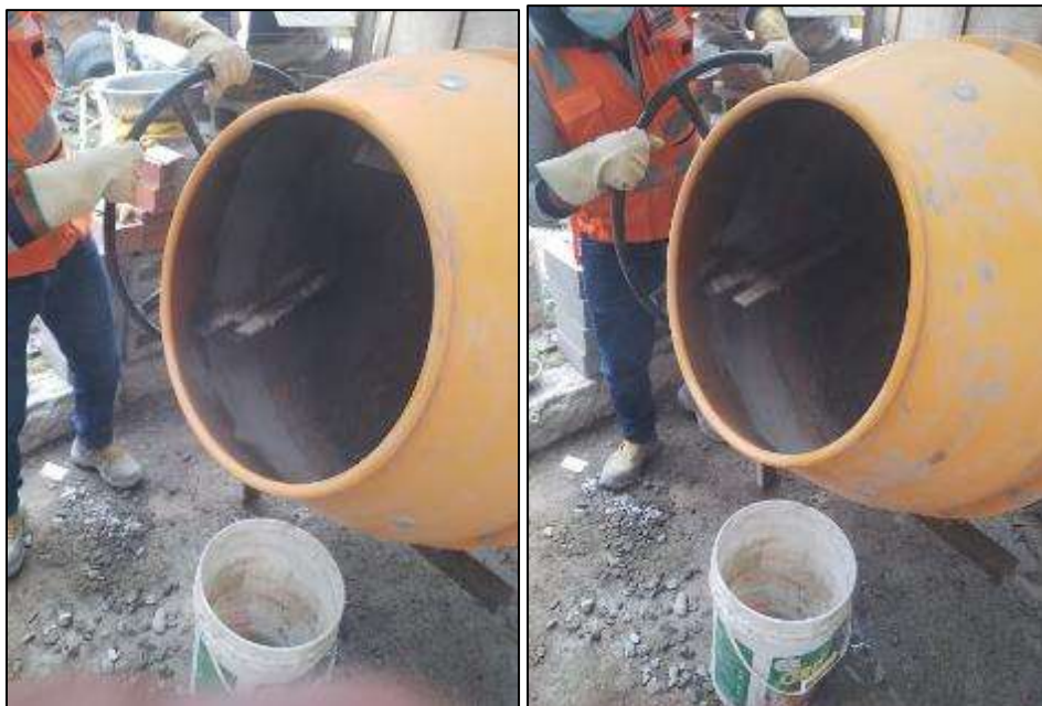
Figura 08: Proceso de mezcla de los agregados (sin aditivo) Fuente: Elaboración propia
