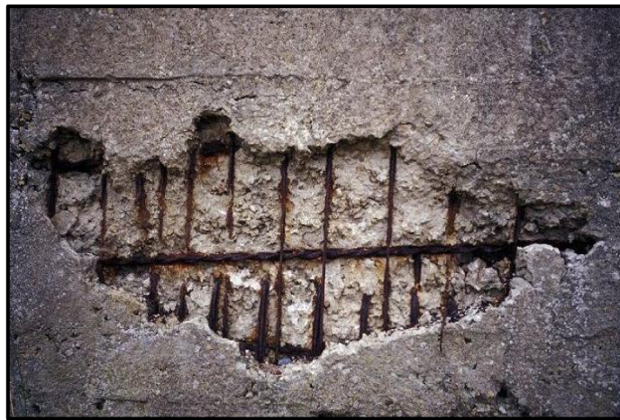
Figura 4. Erosión de las paredes en canales de drenaje.
