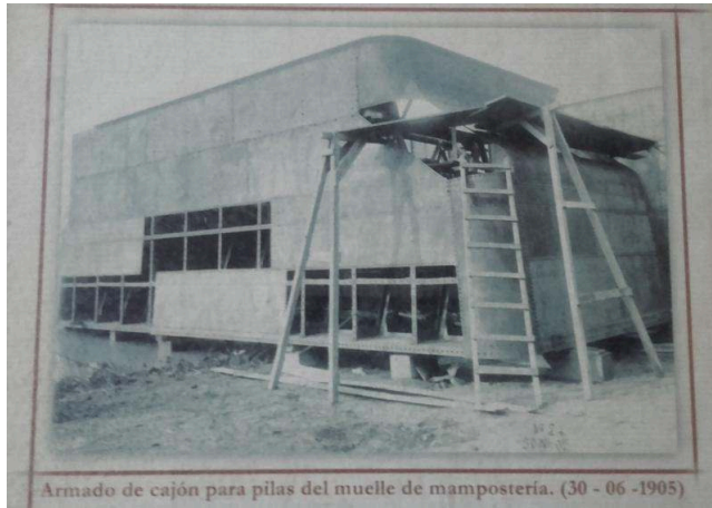
Figure 3 – Caisson métallique en cours de montage vers 1905 (Source : ENAPRO)
