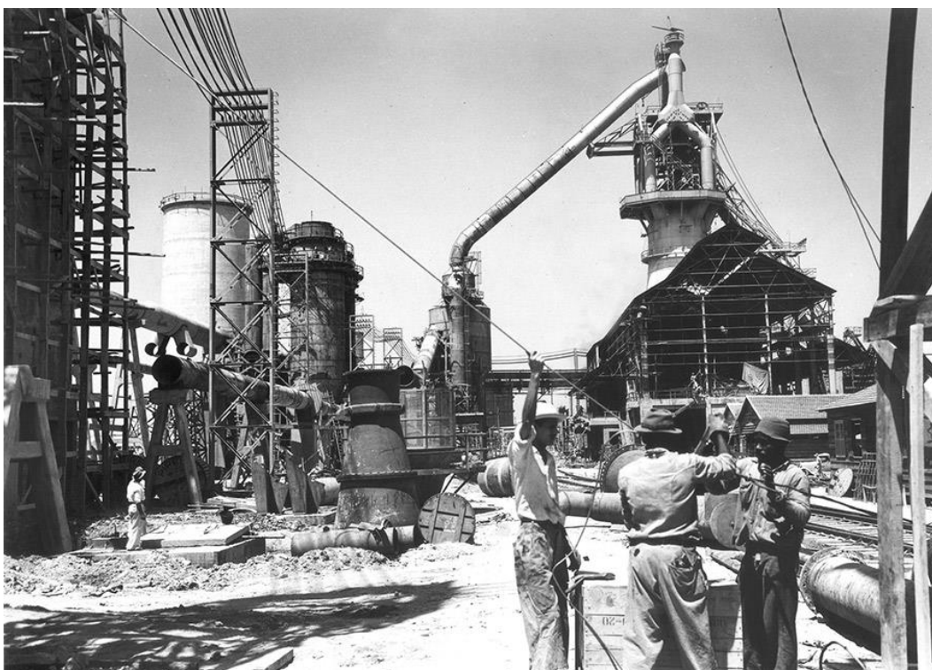
Figura 8 - Obras de construção da CSN
