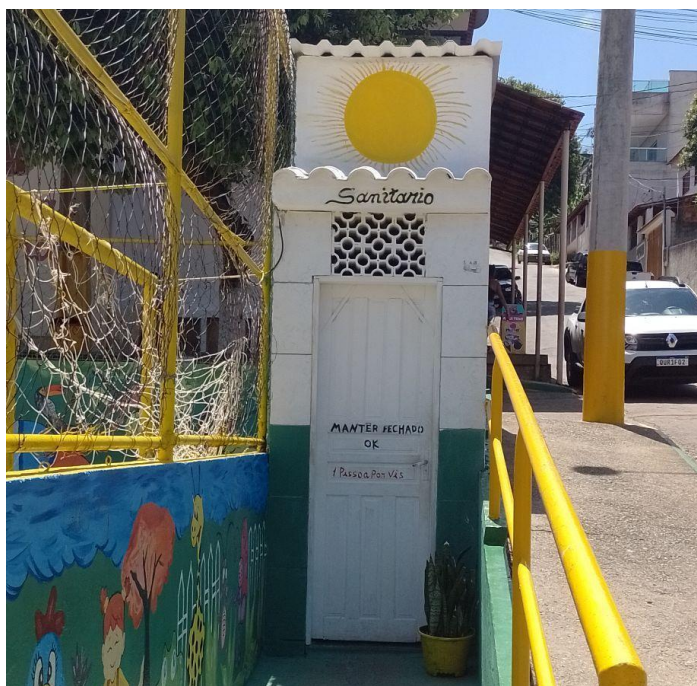
Figura 21 – Banheiro da Praça Rev. Adriano Monteiro
