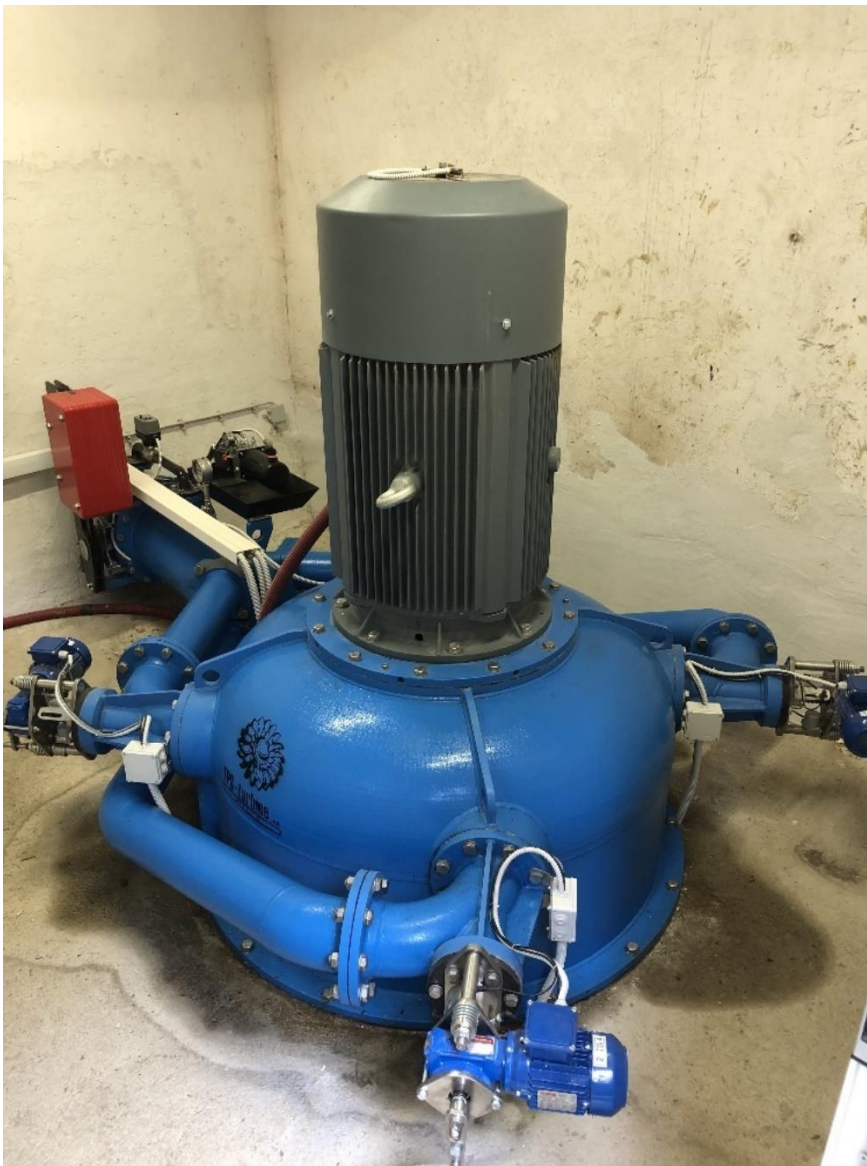
Slika 3.6: Štirišobna Pelton turbina za MHE Gosak
