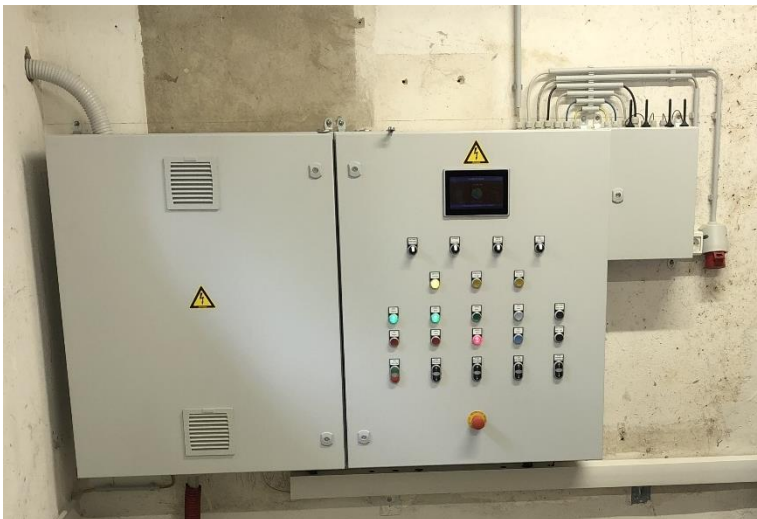
Slika 3.4: Elektro omara v strojnici MHE Gosak
