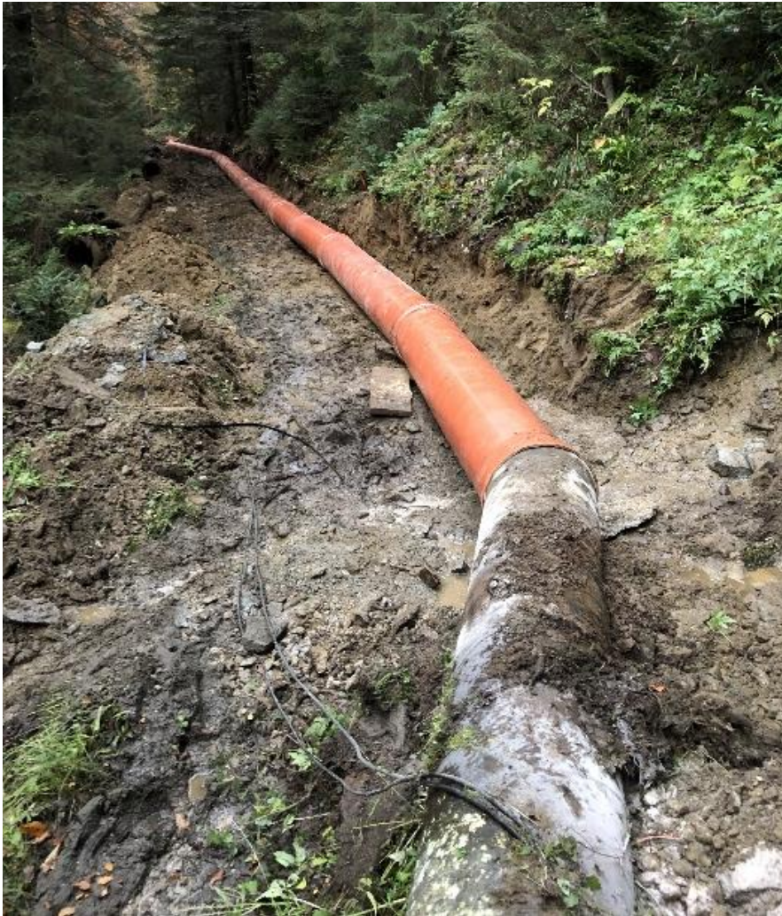
Slika 3.3: Cevovod za MHE Gosak
