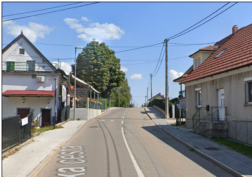
Slika 4-7: Ožina zaradi pozidave na Falski cesti (R3-705/1432) [14]
