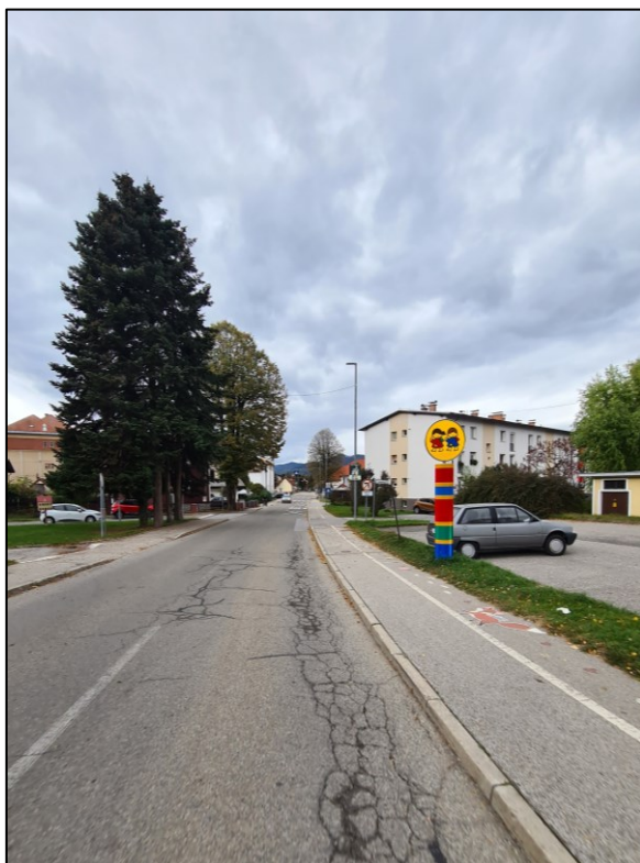
Slika 4-3: Kolesarska steza na Kolodvorski ulici v Občini Ruše
