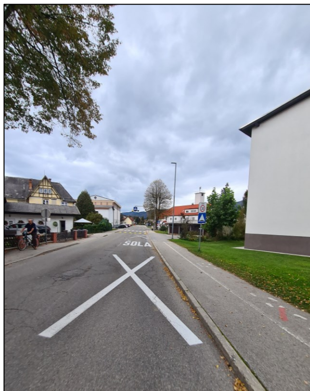
Slika 4-4: Kolesarska steza na Kolodvorski ulici v Občini Ruše
