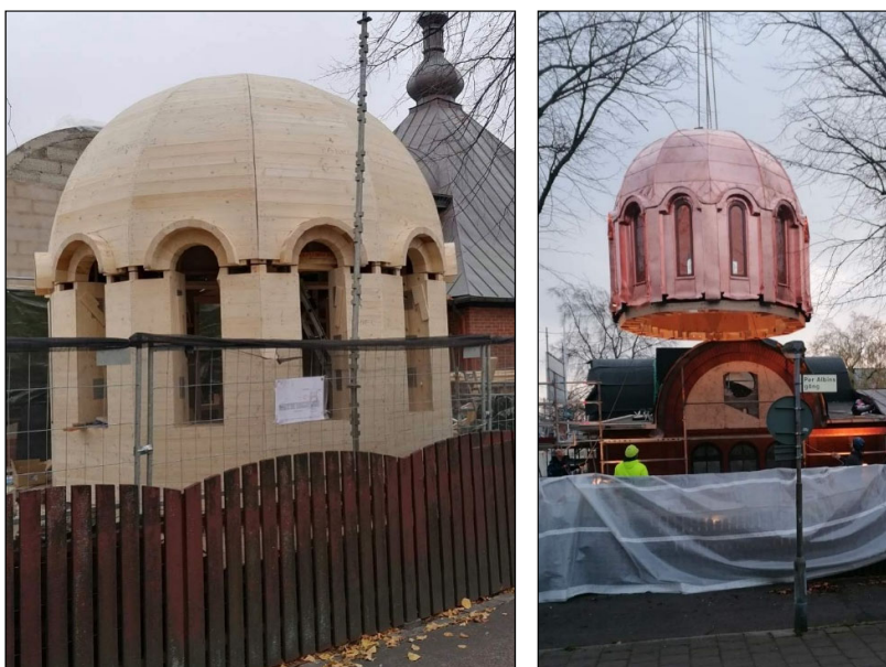
Slika 6. Konstrukcija krova u fazi montaže
