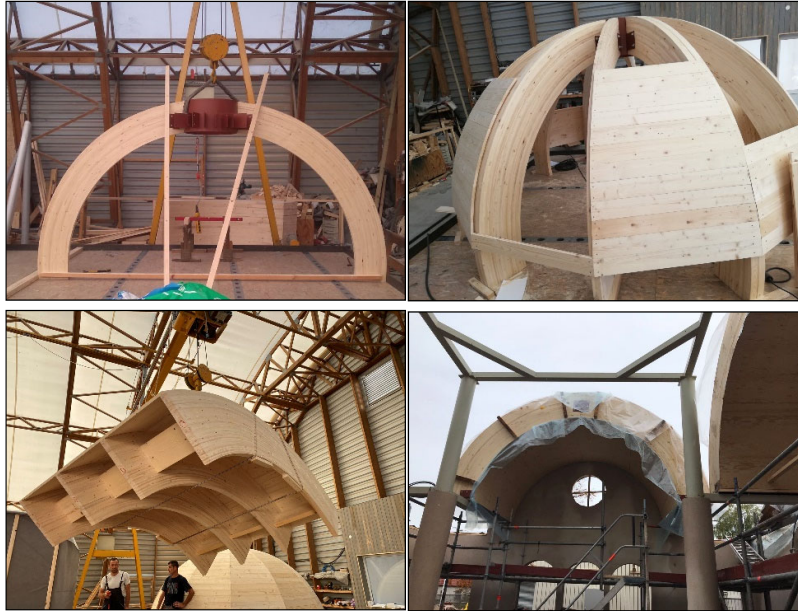
Slika 3. Konstrukcija krova u fazi izrade i montaže
