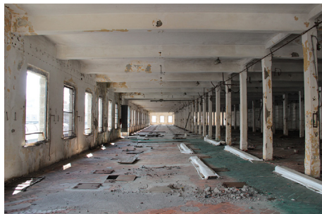
Figura 4. Sitges de gra "Hennebique". Vista dels espais interiors
