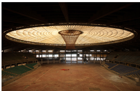
Figura 7. Palau d'Esports, Gènova. Detall de la interessant estructura de la teulada
