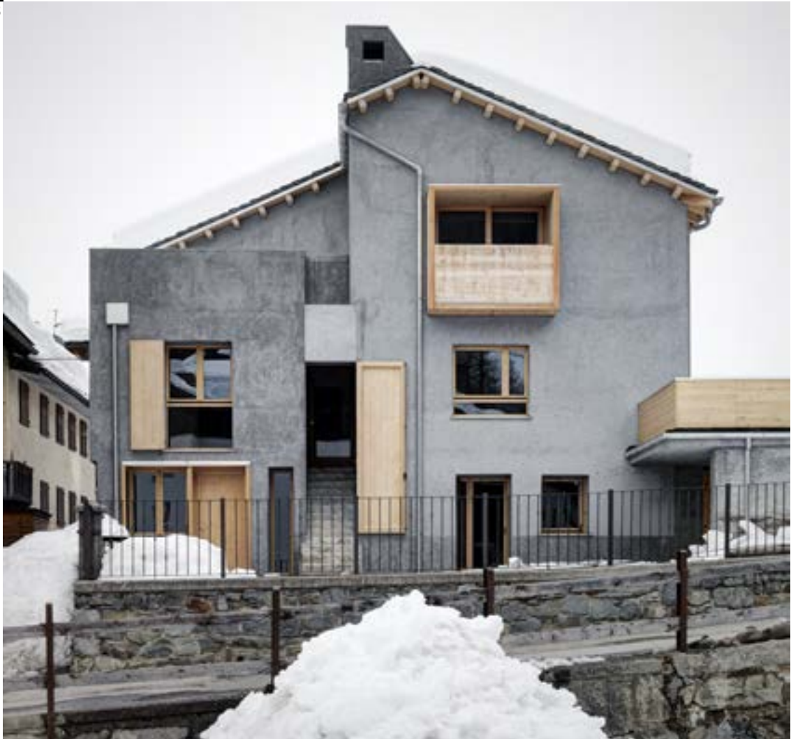
Fig. 4-5 ES arch, Enrico Scaramellini, Casa VG, Madesimo (SO), 2017. Ristrutturazione, situazione ante e post intervento (foto post-intervento Marcello Mariana).
