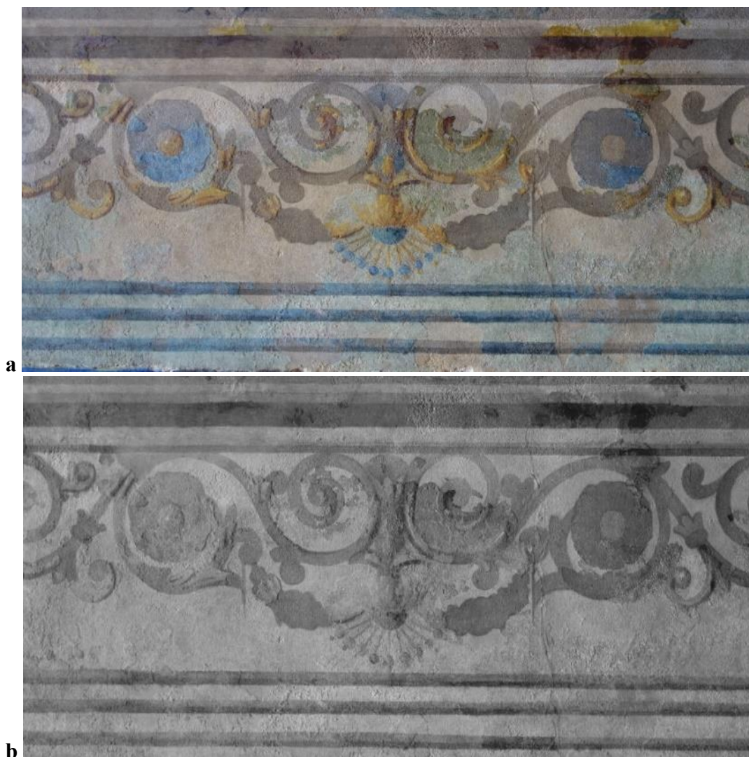
Figura 8. a) Pormenor da zona central da moldura do painel “Cristo cai pela primeira vez”, onde é possível distinguir as zonas de policromia original e as zonas de reintegração em diferentes tons de cinzento; b) mesmo pormenor, a preto e branco.
