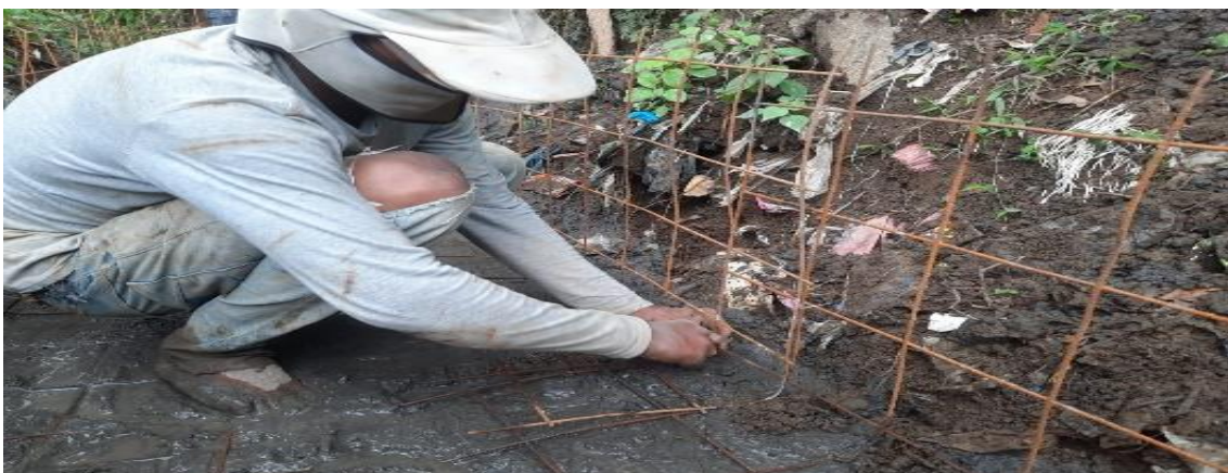
Gambar 1. Proyek Peningkatan Jaringan Irigasi Desa Kedisan
