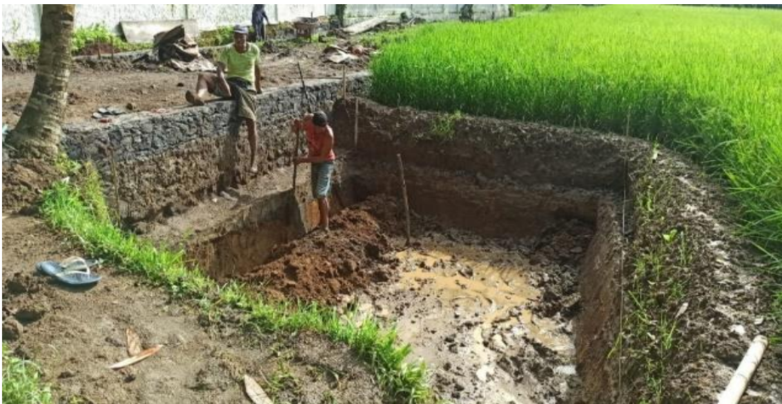
Gambar 3. Proyek Ketahanan Pangan Desa (Jalan Usaha Tani)
