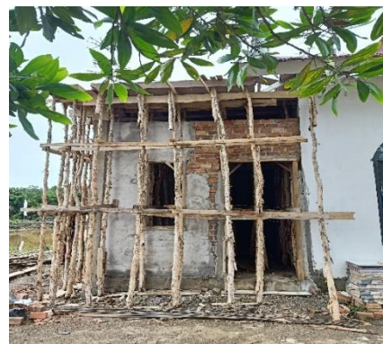
Gambar 4. Pembangunan rumah instalasi
