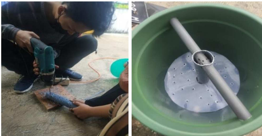
Gambar 2. Proses Pembuatan Komposter
