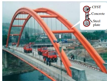
(d) Wangcang east river Bridge [16]
