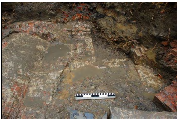
FIG. 16 Enkele kleine bakstenen funderingen (S9, S11 en S12).
