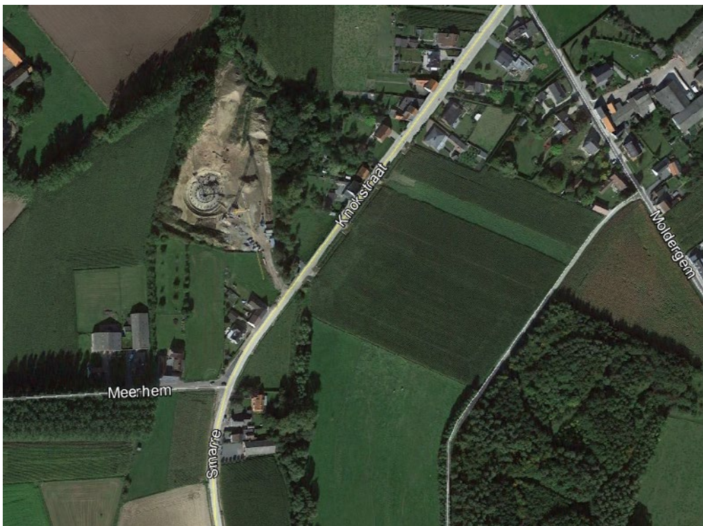
Fig. 1 Beeld van de aan de gang zijnde werken voor de aanleg van de rioolwaterzuiveringsinstallatie (©Google Earth).
