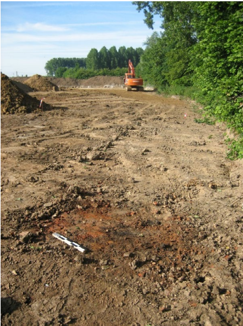
Fig. 11 Zicht vanuit het noorden met op de voorgrond één van de kuilen met slecht gebakken bakstenen (© Onroerend Erfgoed).
