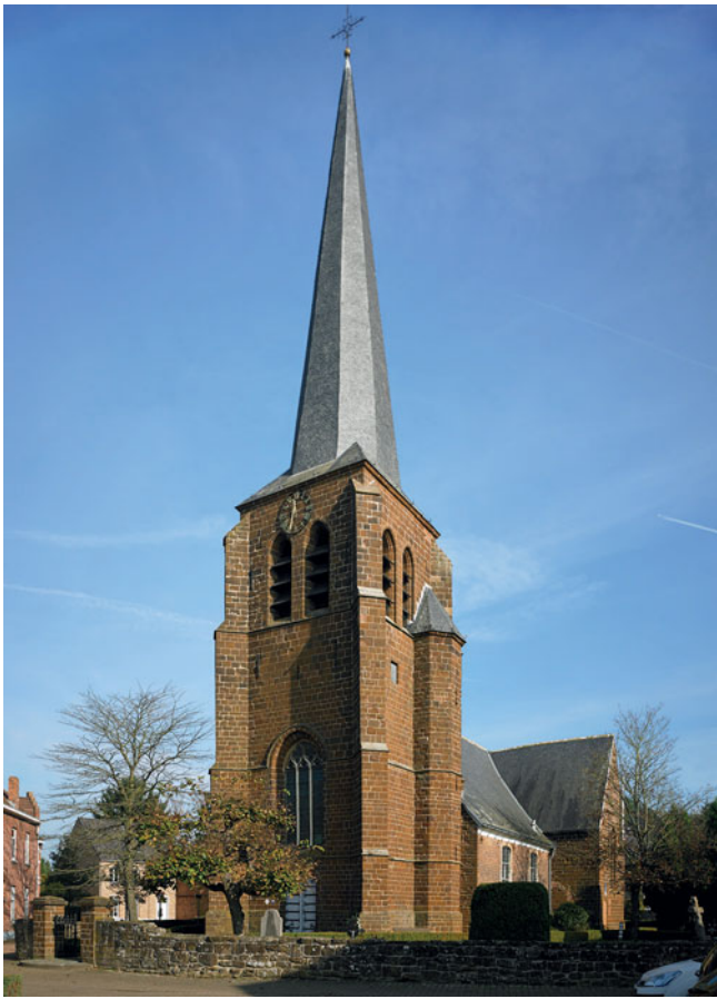
FIG. 13 De toren van de Sint-Pieterskerk in Testelt werd in 1511 gebouwd met ijzerzandsteen uit Langdorp. The tower of St Pieter's church in Testelt was built in 1511 using ironstone from Langdorp.
