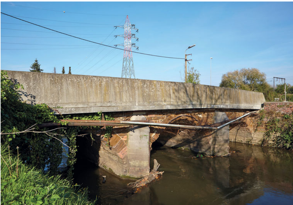
FIG. 27 De Dijlebrug in Wilsel werd gebouwd in de periode 1768-1777, in het kader van de aanleg van de Aarschotsesteenweg, een privéonderneming gefinancierd door de hertog van Arenberg. De onderbouw van de brug bestaat grotendeels uit ijzerzandsteen. De brug is sinds 2007 beschermd als monument.
