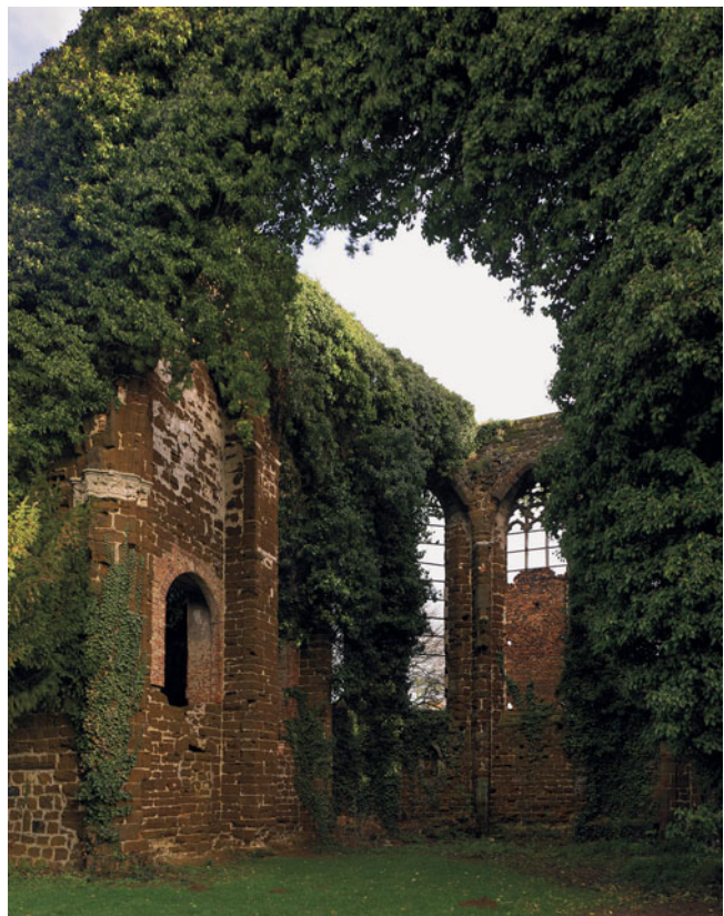
FIG. 51 De met klimop overgroeide ruïnes van de Sint-Janskerk in Diest. In de 20ste eeuw werd ijzerzandsteen steeds meer geassocieerd met begrippen als 'natuur' en 'authenticiteit'. The ivy-covered ruins of St Jan's church in Diest. In the 20th century, ironstone was increasingly seen as 'natural' and 'authentic'.
