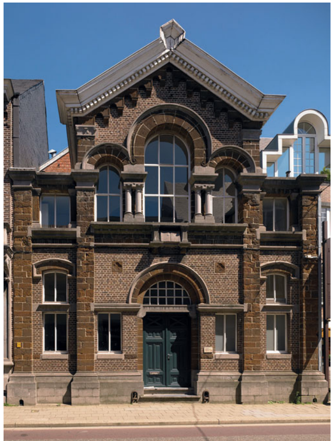
FIG. 39 In 1892 stichtte dominee E. Van Dissel de ‘Vereeniging in het belang van lijdende Nederlanders verpleegd te Gheel’. In 1901-1902 liet deze vereniging een protestantse kerk annex ontmoetingscentrum in de Stationsstraat bouwen door August Leurs. Het gebouw staat sinds 1971 bekend als ‘Van Disselhuis, ontmoetingscentrum voor patiënten van het Openbaar Psychiatrisch Ziekenhuis’. Het huis heeft drie traveeën en twee bouwlagen en bestaat grotendeels uit baksteen. De lisenen en de borstwering bestaan uit grote blokken ijzerzandsteen, vermoedelijk afkomstig uit de groeve Colinez in Kelbergen. In 1892, the Revd E. Van Dissel started the ‘Foundation for the Dutch patients who are cared for in Gheel’. In 1901-02, this foundation asked August Leurs to build a Protestant church cum community centre in Stationsstraat. The building has been known since 1971 as Van Dissel House, a meeting place for patients of the local psychiatric hospital. The house has two storeys and three bays and is largely brick-built. The lesenes and the parapet are made of large blocks of ironstone, probably from the Colinez quarry in Kelbergen.
