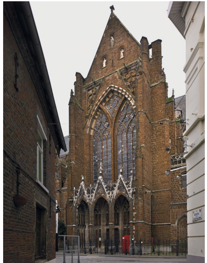
FIG. 45 Het zuidelijke transept van de Sint-Sulpitiuskerk in Diest kreeg in de periode 1885-1891 een nieuw, neogotisch portaal. Between 1885 and 1891, the southern transept of St Sulpitius church in Diest was given a new, Neo-Gothic portal.
