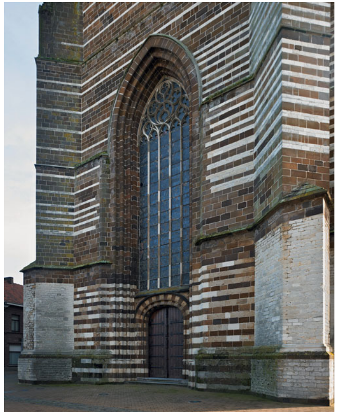
FIG. 4 De Onze-Lieve-Vrouwkerk in Aarschot: portaal van de toren met ‘speklagen’ van ijzerzandsteen en Gobertangesteent. The Church of Our Lady in Aarschot: the tower portal with decorative alternating bands of ironstone and limestone.
