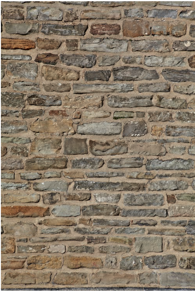
FIG. 30A Kerktoren van Oostkerke, zuidwand. Metselwerk in kalkzandsteen van Baincthun. Church tower of Oostkerke. Masonry in Baincthun calcareous sandstone.
