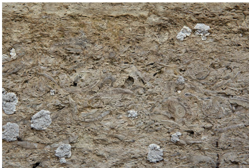
FIG. 17 Kalkzandsteen van Baincthun in het gedichte portaal van de westtoren. Schelpenrijke lichtbruine tot beige variëteit met dikschalige volledig gerekristalliseerde tweekleppigen en slakjes. Baincthun calcareous sandstone in the sealed portal of the western tower. Light-brown to beige variety, rich in thick-shelled, fully recrystallized Pelecypods and gastropods.
