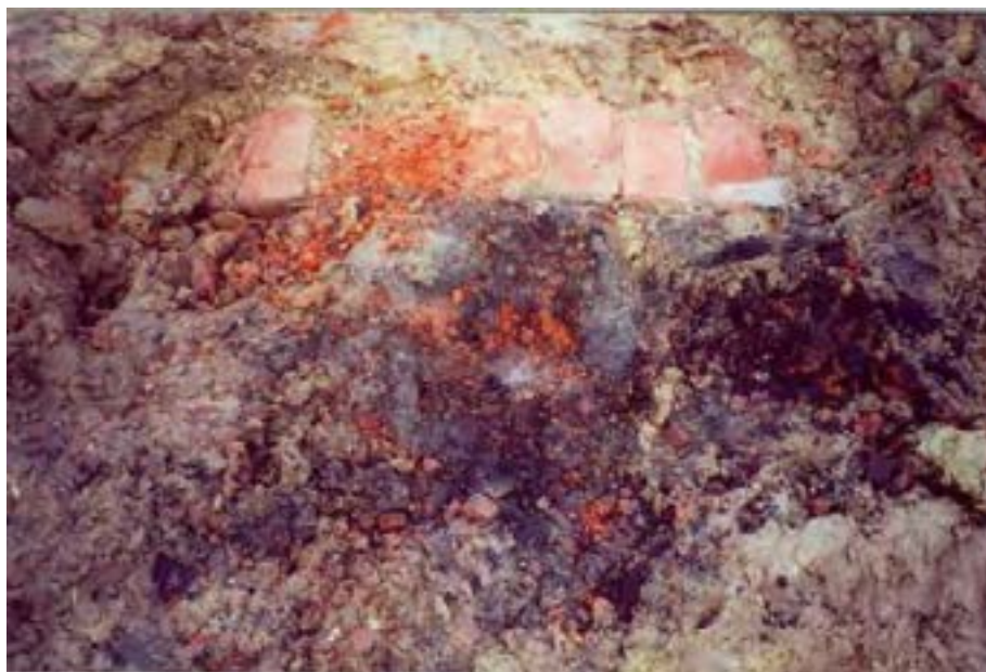
Foto 5. Fundering in metselwerk in de aanlegstrook van de Aquafin-pijpleiding langsheen P2. (Foto H. Delvaux)
