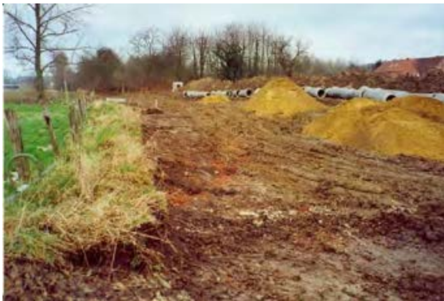
Foto 3. Aanlegstrook van de Aquafin-pijpleiding langsheen P2. (Foto H. Delvaux)
