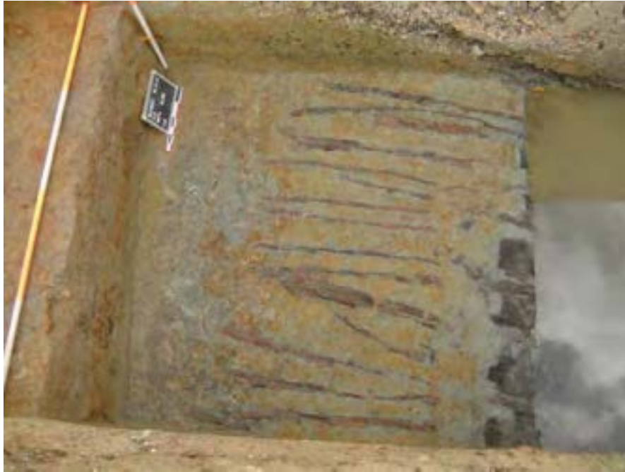
Foto 45. Laag L8 in vlak VL5 van werkput WP4. Horizontaal naast elkaar geplaatste houten takken van zwarte els en veenplaggen als versterking van de mottebasis. (Foto W. Sevenants)
