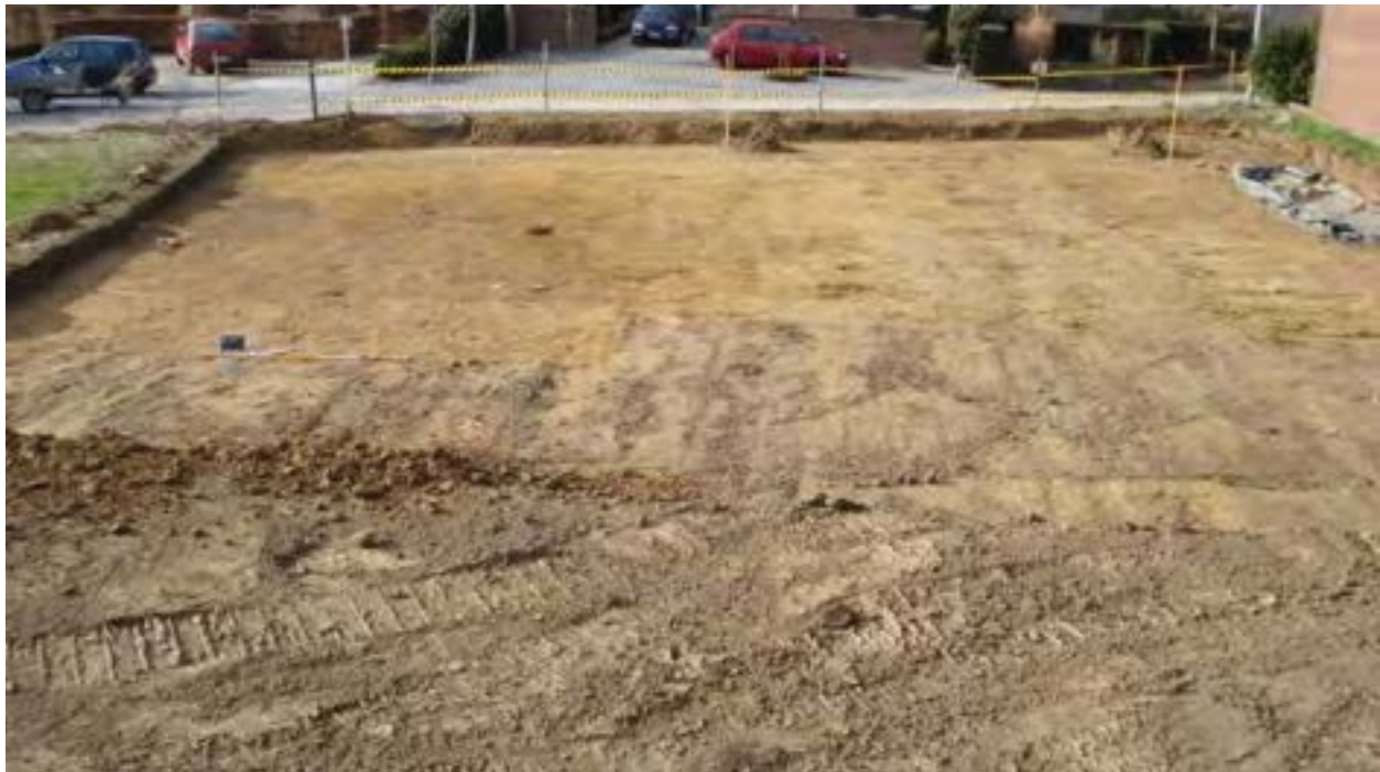
Foto 27. Werkput WP1 net na het afgraven van de teelaarde. (foto W.Sevenants)
