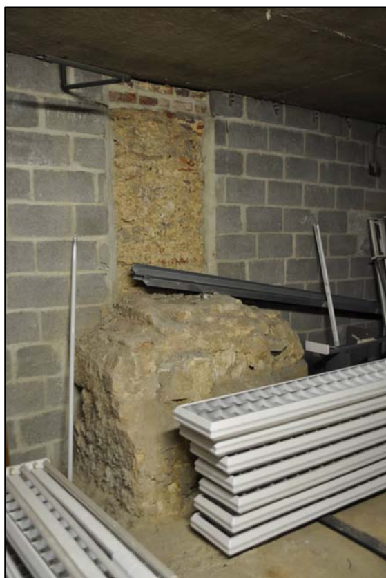
Afb. 22. Oude fundamenten in recente kelder onder de oostelijke vleugel van de Carré. Foto: ARON bvba
