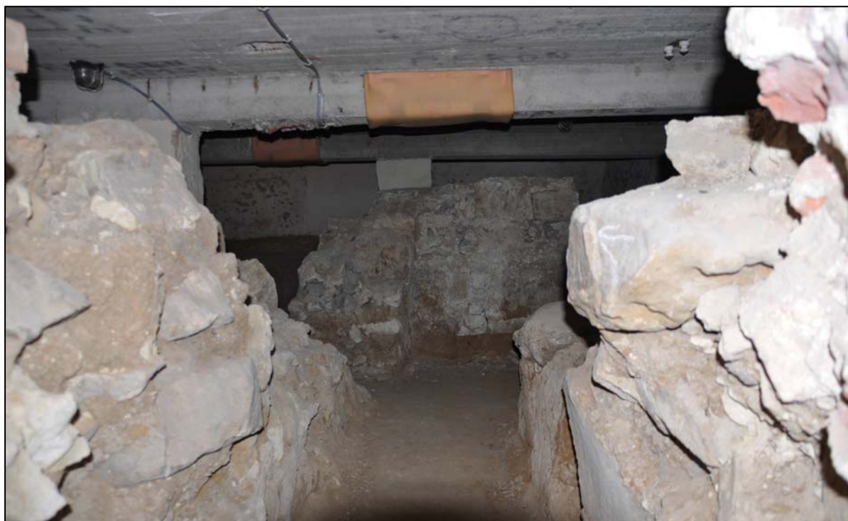
Afb. 20. Funderingen onder de zuidwestelijke hoek van de Carré. Foto: ARON bvba
